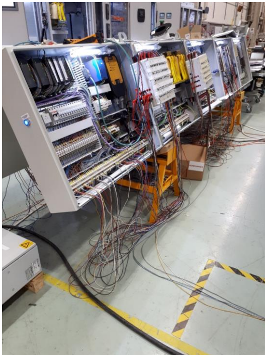
KUVA 28. Testausjohtimet vedetty lattiaa pitkin
