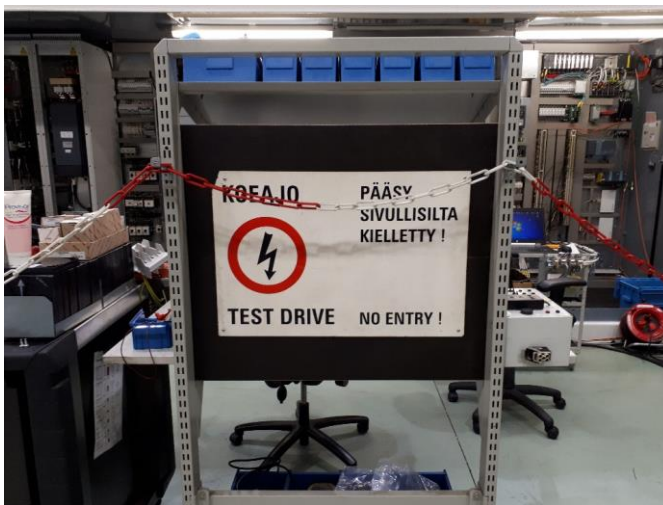
KUVA 12. RTG-sähköhuoneiden testausalueen varoituskilpi
