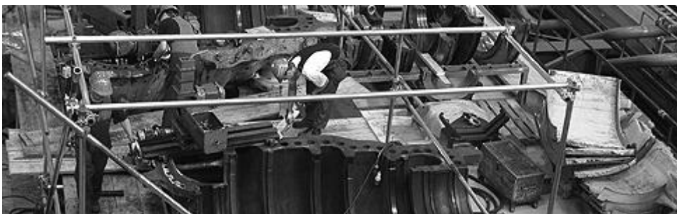
KUVA 2 Telatek Service kykenee vaativiin asennus- ja kunnossapitotoimiin (4)
