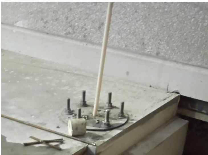
Kuva 6. Pilarinostimen ankkuripultit asennettuina paikoilleen.
