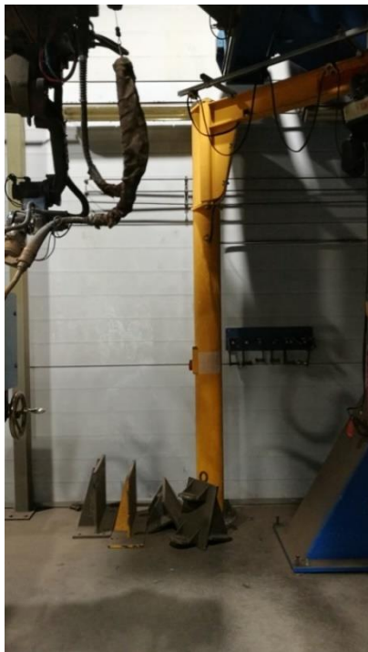
Kuva 4. Pilarinostin ja runkojen kiinnikkeitä.
