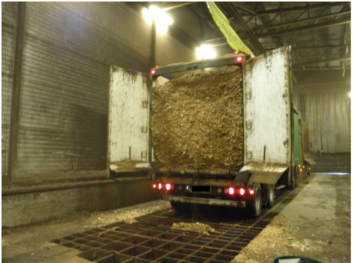
Kuva 11. Polttoaineen vastaanottoasema, peräpurku.
