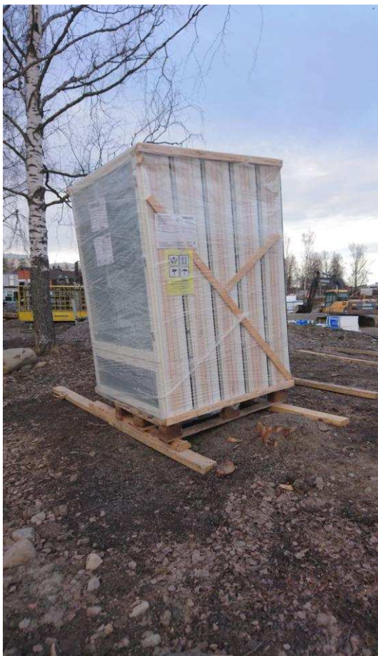
Kuva 7. Materiaalitoimittajien suojat eivät pelkästään riitä suojaamaan materiaaleja. Huonosti suojattuihin materiaaleihin voi jäädä rakennusaikaista kosteutta. Kuva ei ole pilottikohteesta.
