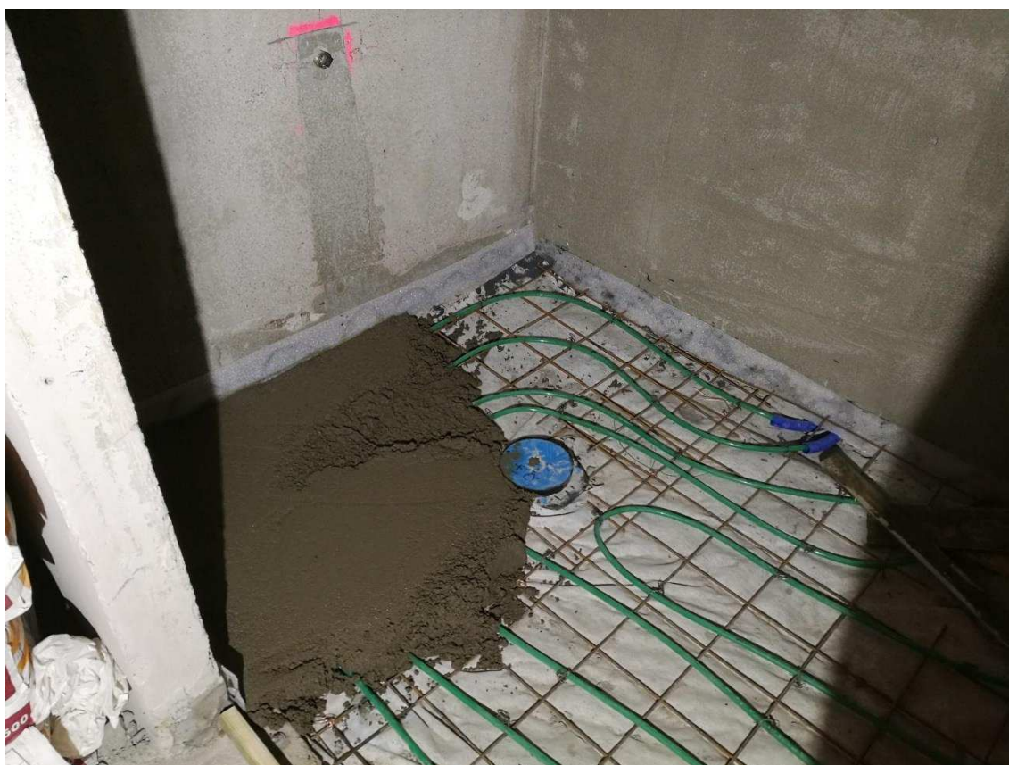
Kuva 10. Kylpyhuoneen lattian toteutus pikamassalla.
