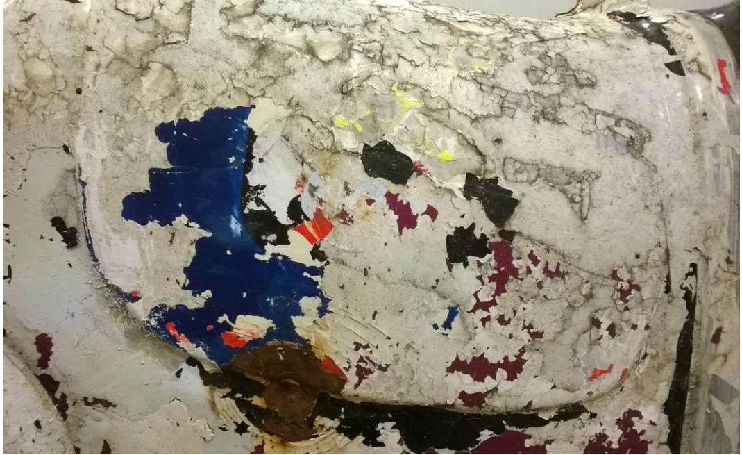
Kuva 9. Maalikerrokset olivat monin paikoin valmiita tippumaan pelkämästä kosketuksesta. (Kinnunen 2017)
