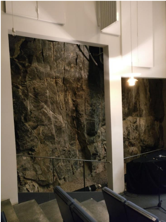
Kuva 17. Maahanrajoittuva kalliin louhittu seinäpinta esiintymistilassa Sandelsin koululla. Kuvan ottoapaikka on merkattu kuvaan 17. punaisella nuolella.
