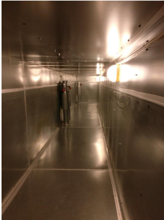
Kuva 11. Tuloilmakanava ja luokkiin lähteviä hajotuksia Poikkilaakson koululla
