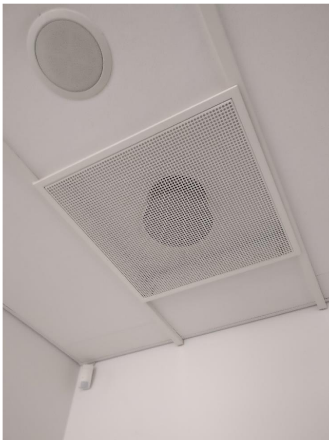
Kuva 21. Tuloilmalaite kokoustilassa
