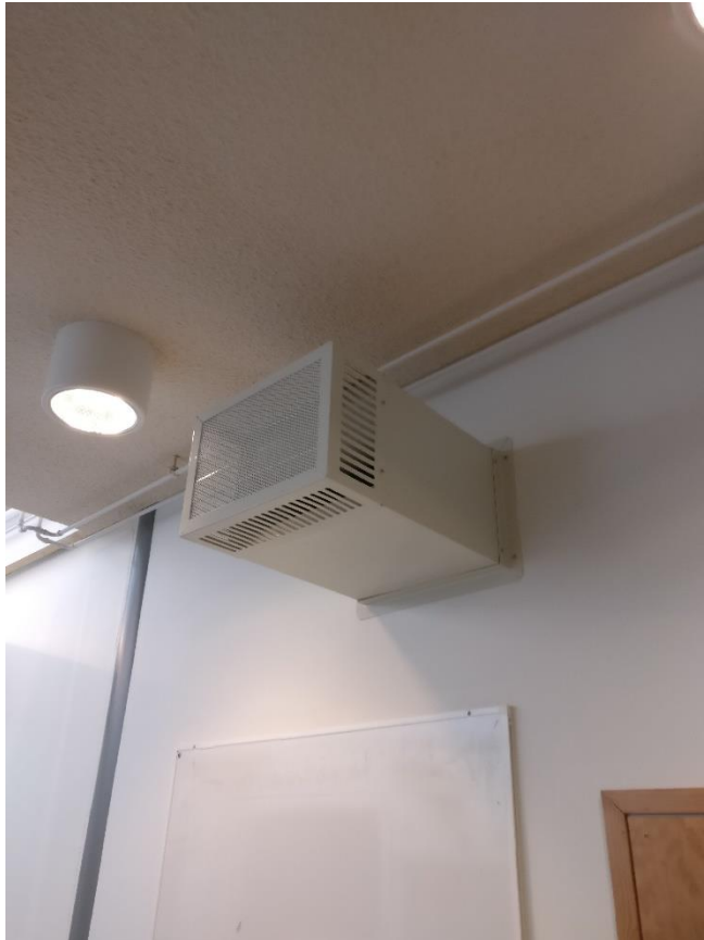
Kuva 15. Siirtoilmalaite Poikkilaakson ala-asteella
