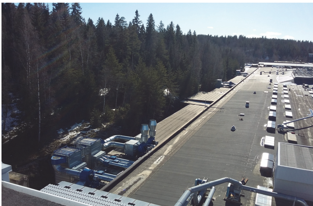
KUVA 2. Uusitun purunpoistojärjestelmän siilot
