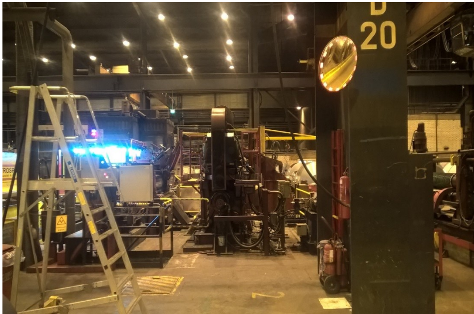
Kuva 6. Sähkötila SK6-umpikaapelitunnelin poistumistie lattiassa.
