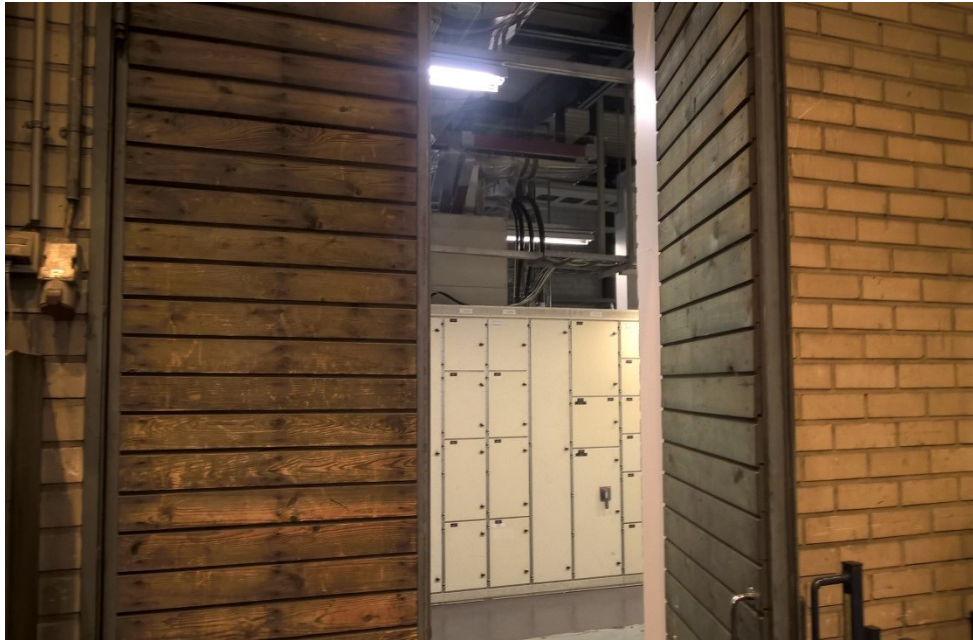
Kuva 8. Sähkötötilan SK8-vanha ulko-ovi
