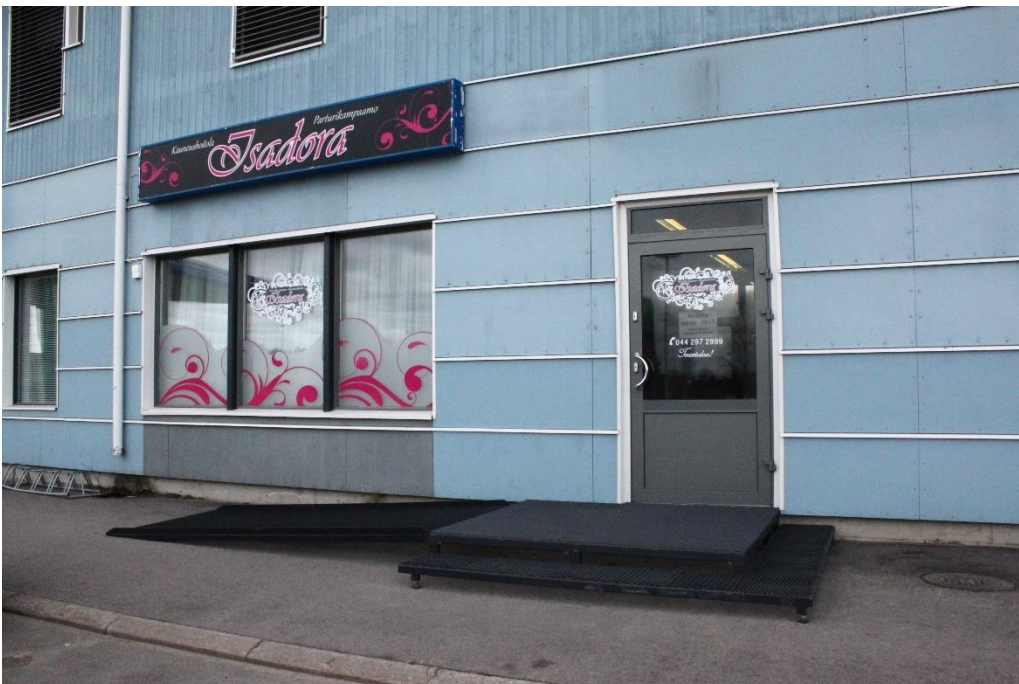
KUVA 1. Isadoran uusi julkisivu
