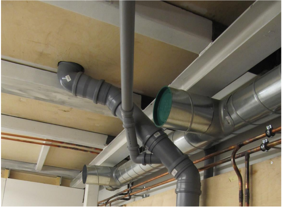
Kuva 10. Asennusharjoituksia haittaava teräsinen runkorakenne.
