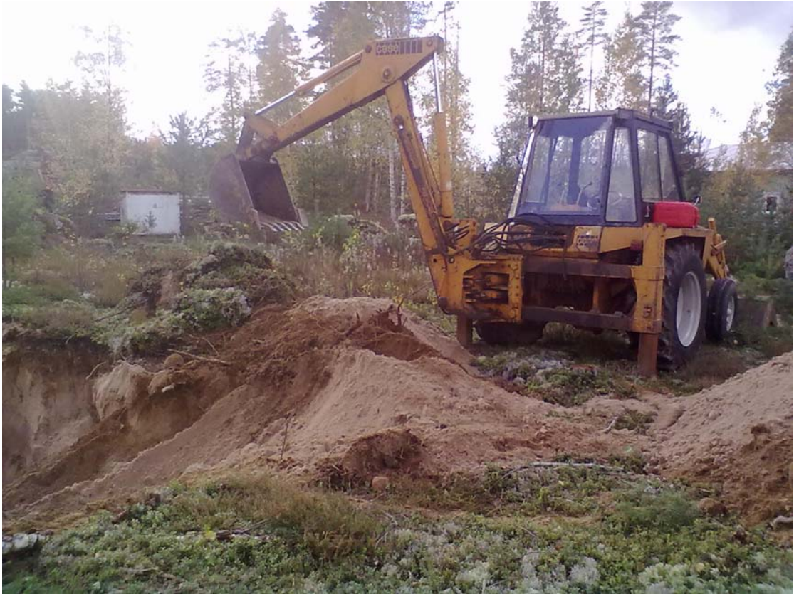
Kuva 4, haruksen valmistelua (Gardemeister 2016)
