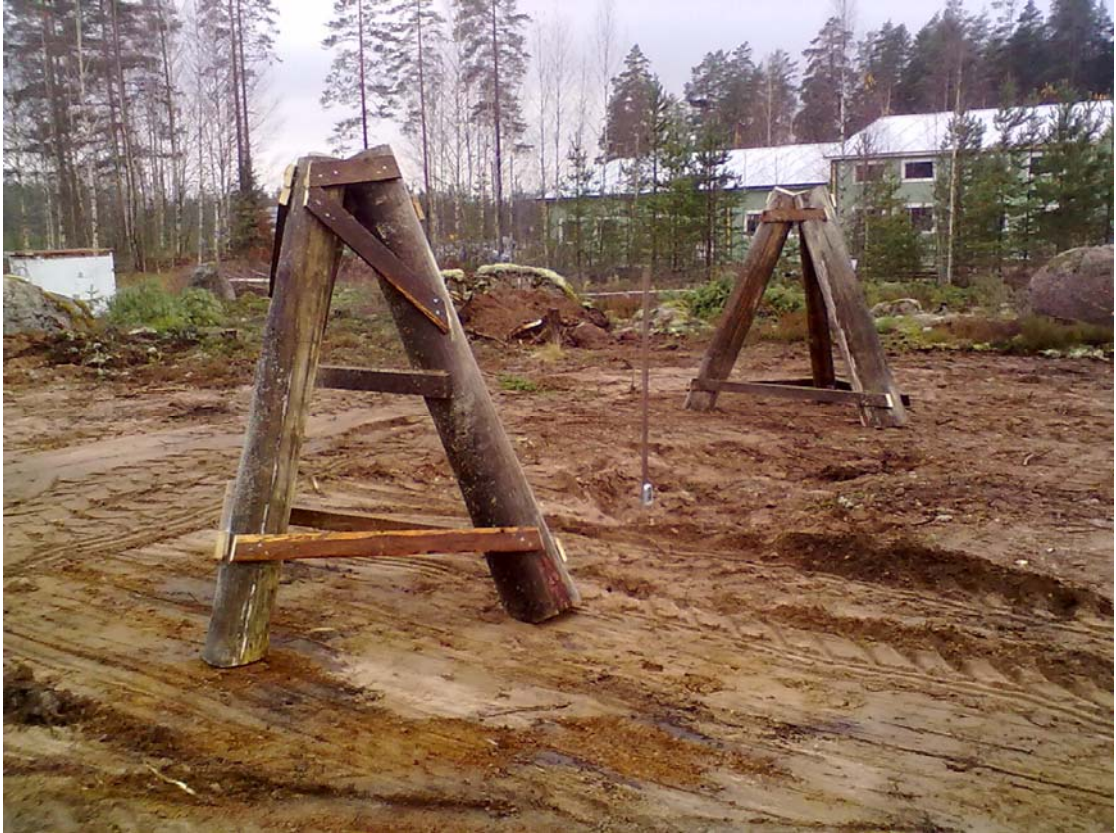
Kuva 5, Harus ja tukipukit valmiina (Gardemeister 2016)
