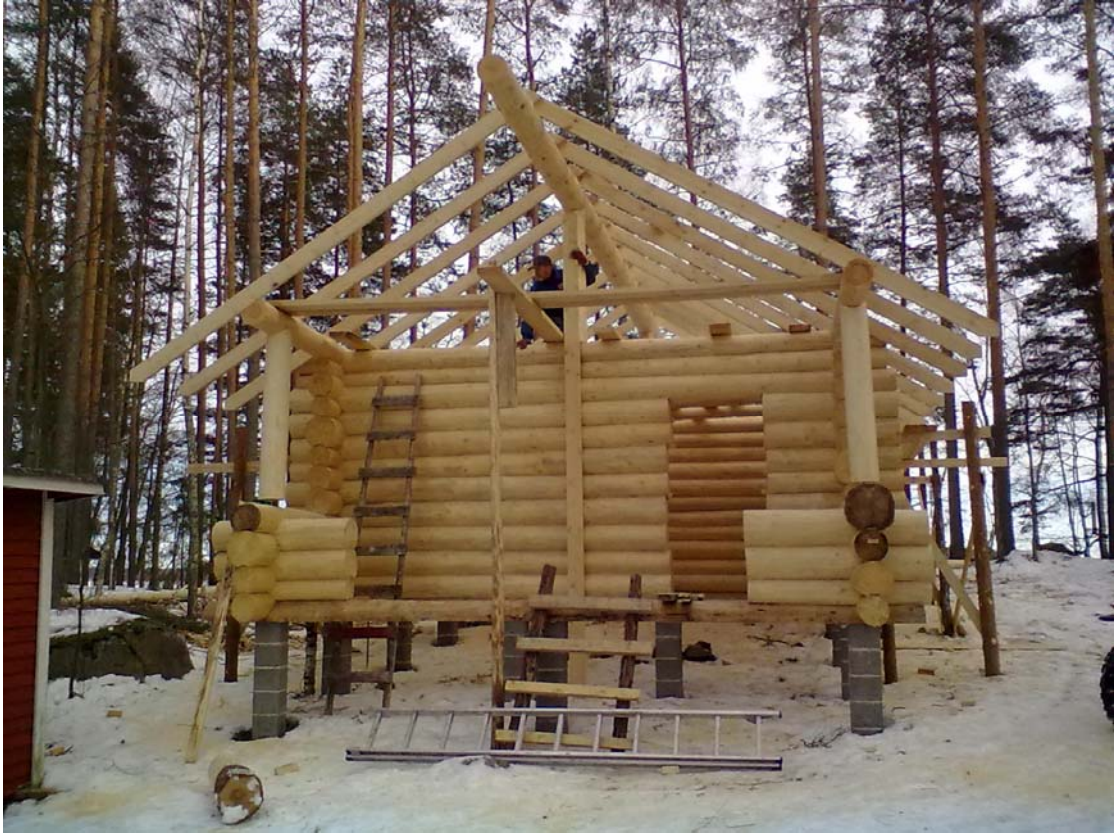
Kuva 2, pilareilla toteutettu kurkihirsi (Gardemeister 2014)
