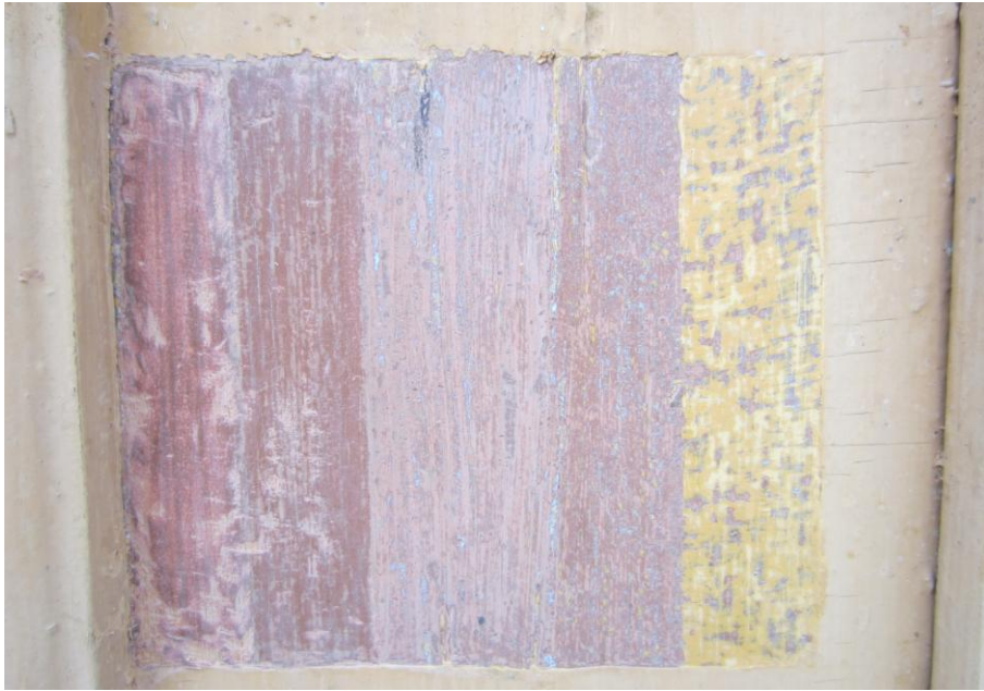
KUVA 1. Vesilahden kirkon julkisivujen väritutkimuksen väriportaikko
