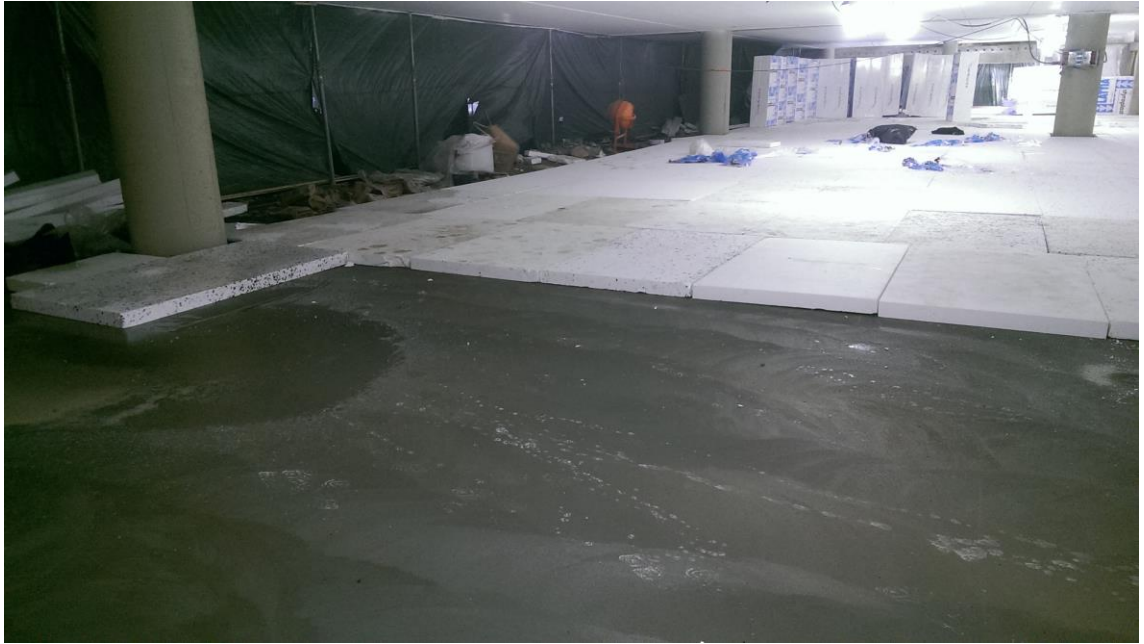
KUVA 27 . Styroxit asennettuna valetun lattian päälle.
