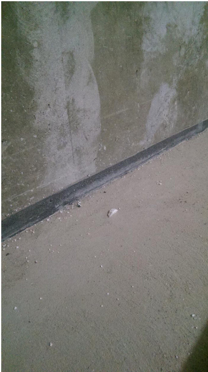
KUVA 10. Seinän ja lattian väliin asennettu solumuovi-irrotuskaista.
