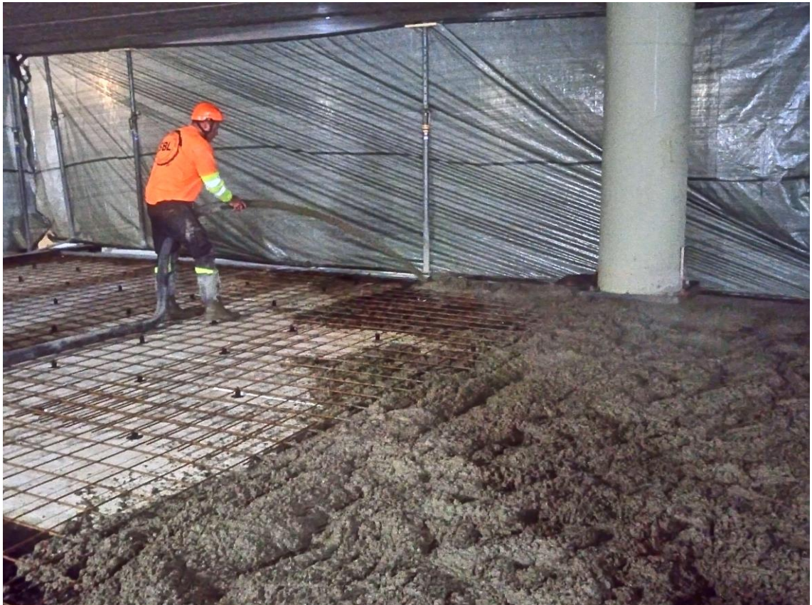
KUVA 20. Betonin valaminen letkulla.
