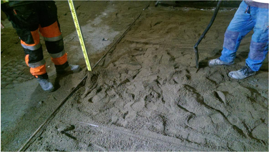
KUVA 5. Metalliputkien asennus oikeaan korkoon.
