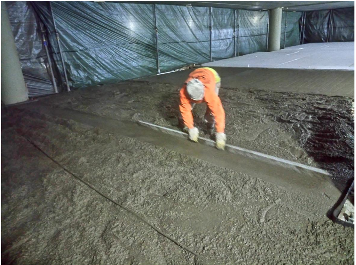
KUVA 23. Betonin levittäminen linjarilla.
