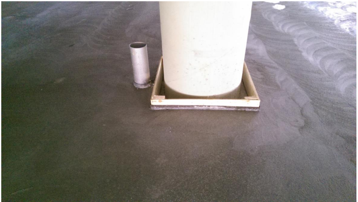
KUVA 9. Pilarin ja putkien irrottaminen lattiasta
