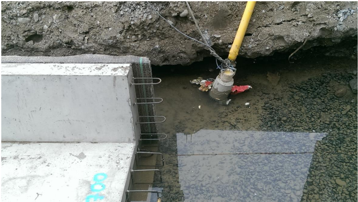
KUVA 7. Uppovesipumppu käytössä putkikanaalia asennettaessa.
