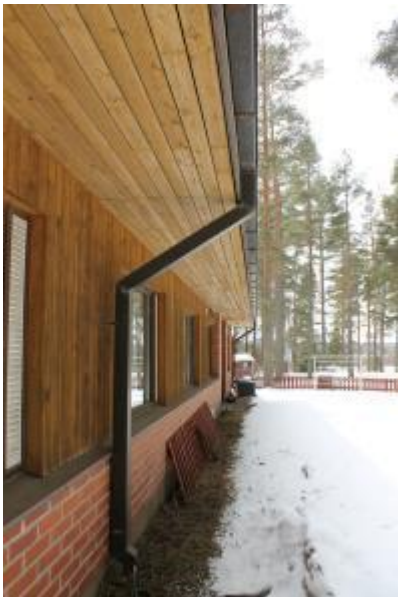
Kuva 21. Rakennuksen rännit ja syöksytorvet.
