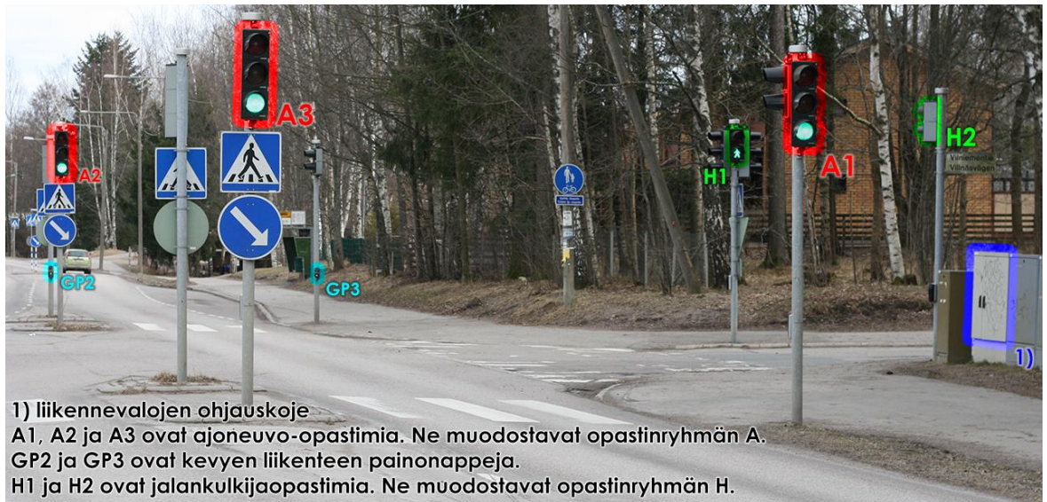
Kuva 1. Tyypillisen liikennevaloliittymän laitteita
