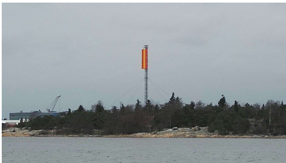
Kuva 5. Rihniemen väylällä sijaitseva harustettu teräsristikkorakenteinen linjamerkki.
