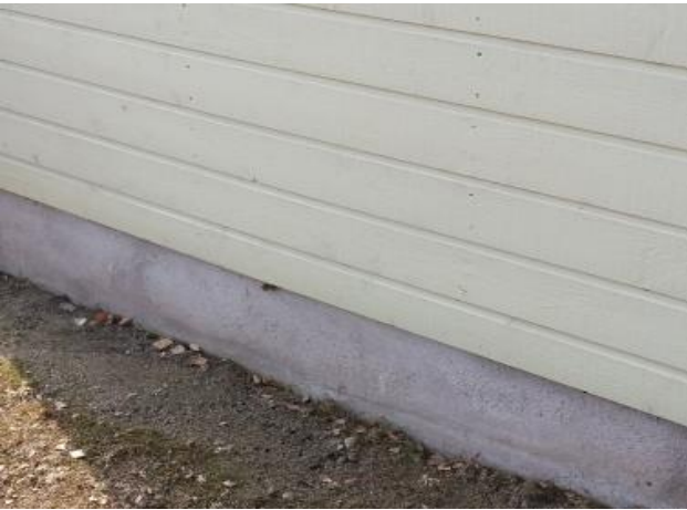
Kuva 15. Autokatoksen ulkoseinä- ja sokkelipinta.
