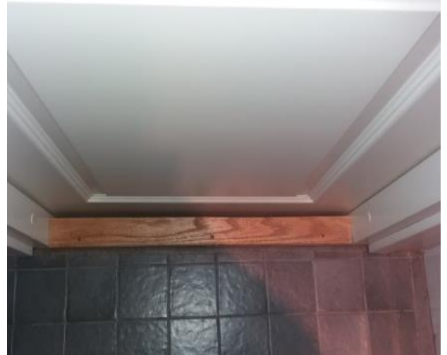
Kuva 50. Oven ja kynnyksen väliin jäävä ilmarako.
