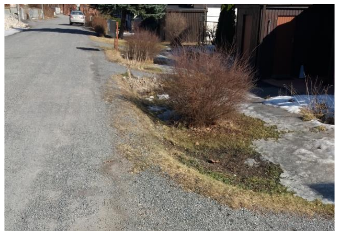
Kuva 2. Etupihalla maanpinta viettää rakennukseen päin.
