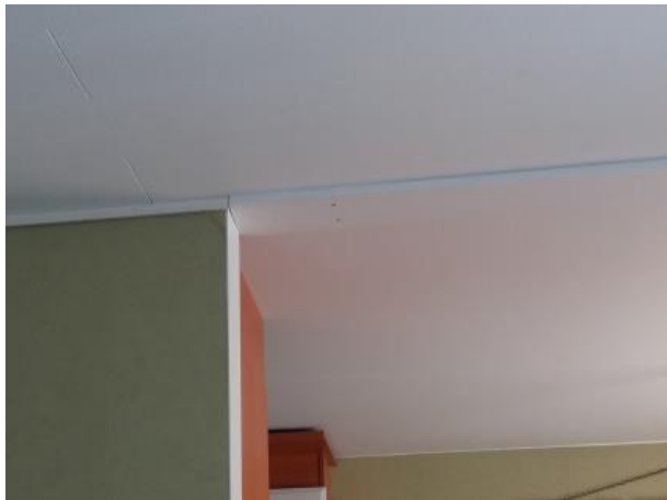
Kuva 55. Keittiön puolella kipsilevyypinta, joka on erotettu olohuoneen puupaneelipinnasta leveällä laudalla.
