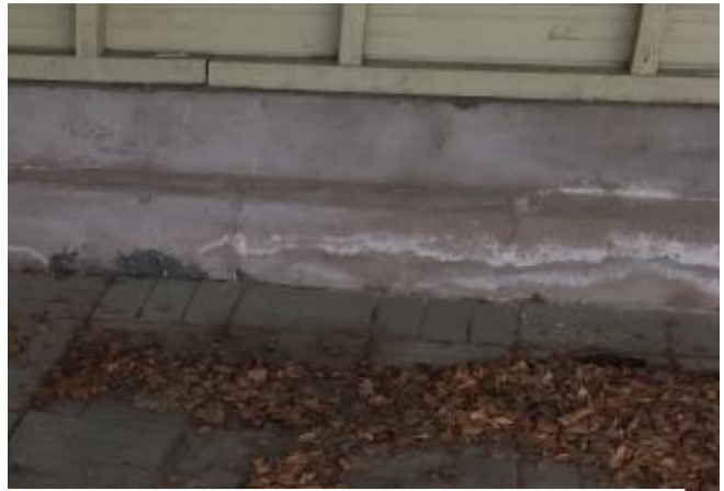
Kuva 14. Kalkkihärmettä sokkelissa.
