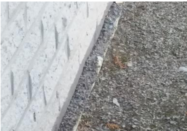
Kuva 9. Sokkelia vasten oleva EPS-eriste.
