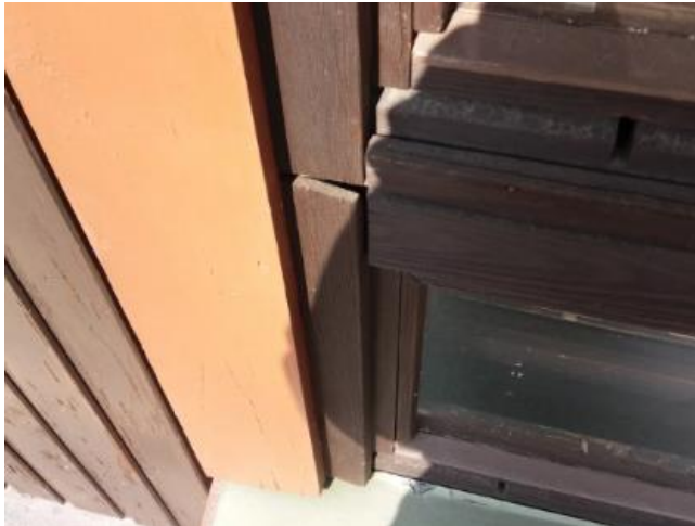
Kuva 43. Parissa ikkunassa ulkopuolinen reunalista on puoliksi irrallaan.
