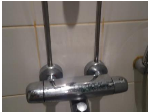
Kuva 48. Laatan saumat värjäytyneet oransseiksi
