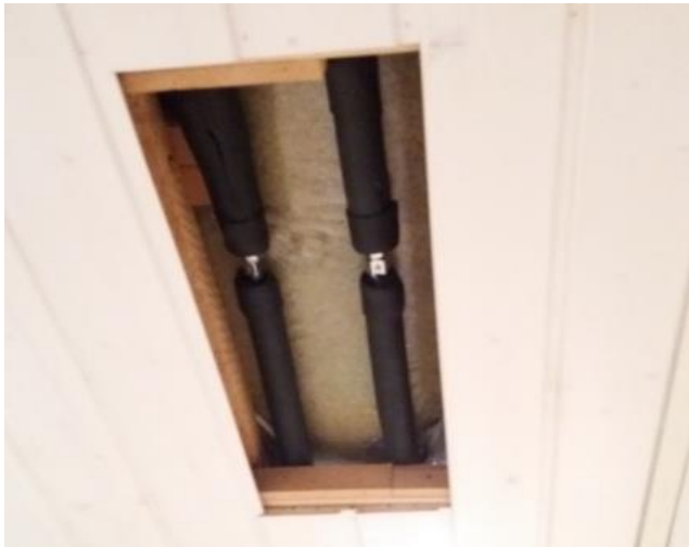
Kuva 49. LVI-tekniikan tarkastusluukku.
