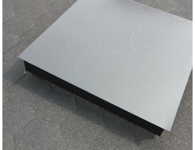
Kuva 36. Vesikaton kulkuluukku.
