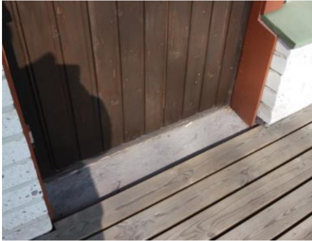
Kuva 41. Parvekeoven betoninen kynnyks.
