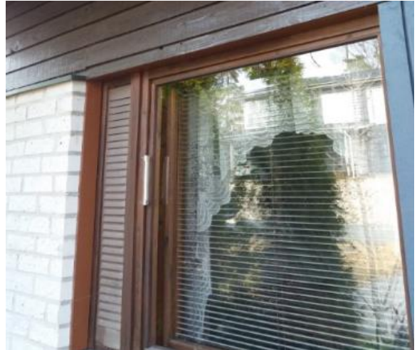
Kuva 44. Ikkuna tuuletusikkunalla.
