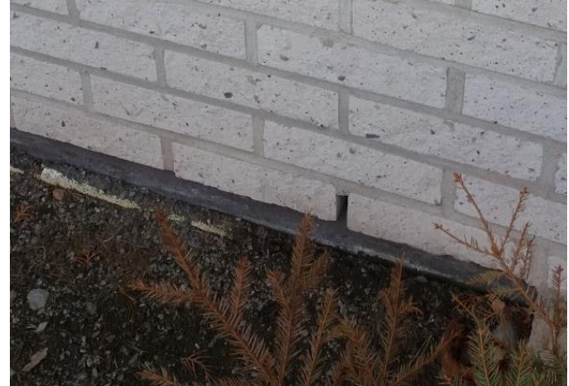
Kuva 26. Liian matala sokkeli.
