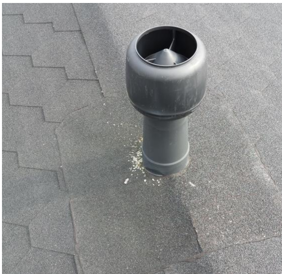
Kuva 33. Poistoilmahuuhallin. Läpivienti tiivistetty oikein.
