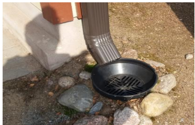
Kuva 11. Autokatoksen hyvässä kunnossa oleva rännikaivo.
