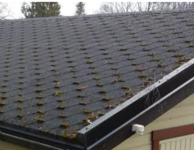
Kuva 17. Vuonna 2011 uusittu huopakate on ehtinyt jo sammaloitua.
