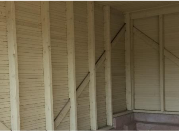
Kuva 12. Autokatoksen sisäpinnat ovat hyvässä kunnossa.
