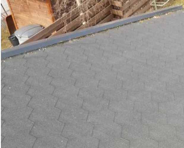
Kuva 35. Vesikatteen pääty pellitetty oikein.
