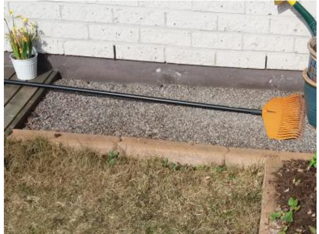
Kuva 6. Oikein tehty sokkelin vierustäyttö.
