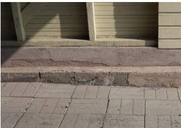
Kuva 10. Perusmuuria vasten näkyvillä oleva EPS-eriste.
