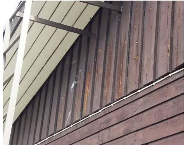
Kuva 30. Kulunutta paneelipintaa.
