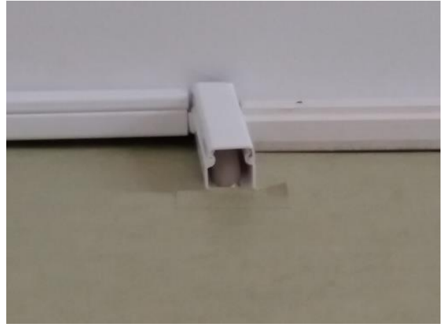
Kuva 54. Kuten kuvasta huomataan, nurkkalistan alla menee sähköjohto keittiöön.
