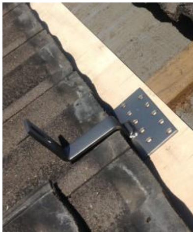
Kuva 10. Tiilikaton teline kiinnitetään tiilin alle. (Puro 2017a)
