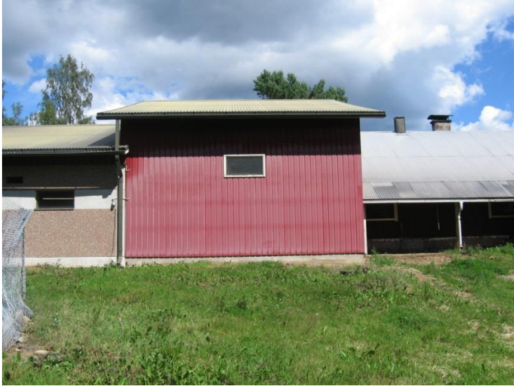
Kuva 12. Aurinkosähköjärjestelmän asennuspaikka, katon lape on etelän suuntaan. (Joutsimatka)
