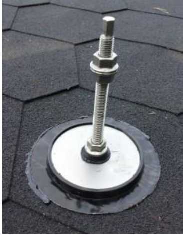
Kuva 9. Huopakaton kiinnike asennettuna paikoilleen. (Puro 2017a)
