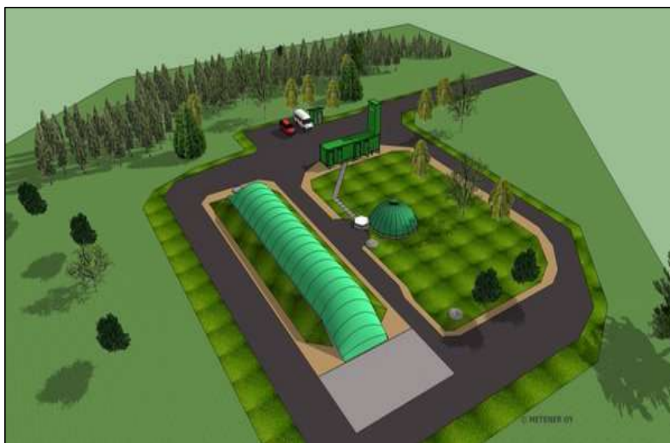
Kuva 16. Havainnekuva panostoimisesta suotopetireaktorilla varustetusta biokaasulaitoksesta (Metener Oy, 2016).
