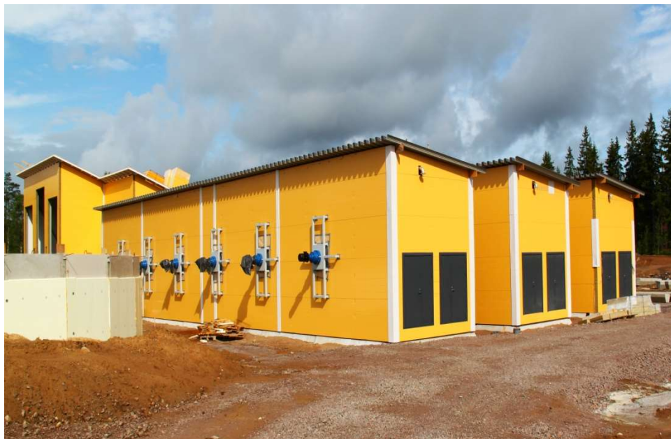
Kuva 15. Haminan Energia Oy:n tulppavirtausmenetelmään perustuvan biokaasulaitoksen modulaarisesti rinnan toimivat reaktorit Virolahdella (BioGTS Oy, 2016).
