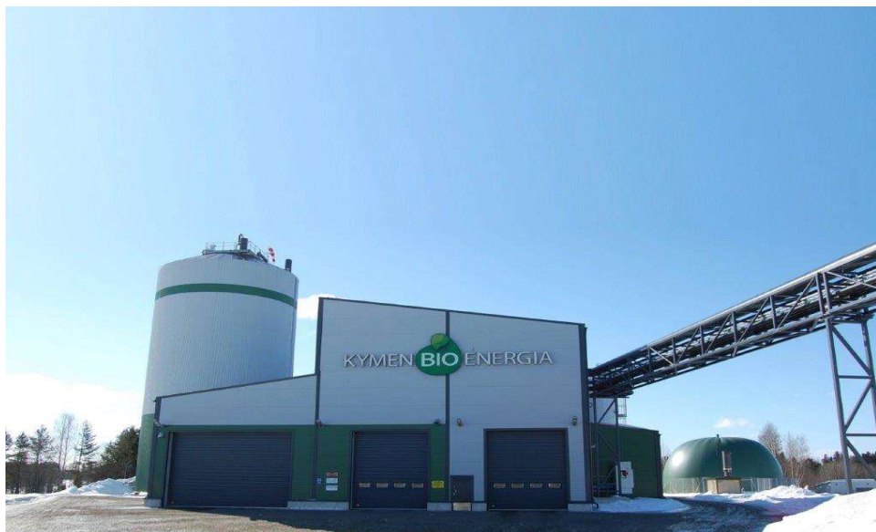
Kuva 14. Kouvolan Vesi Oy:n jatkuvatoiminen, täyssekoitteinen, kaksivaiheinen märkäprosessiin perustuva biokaasulaitos Kouvolassa (Kymenlaakson Jäte Oy, 2016).
