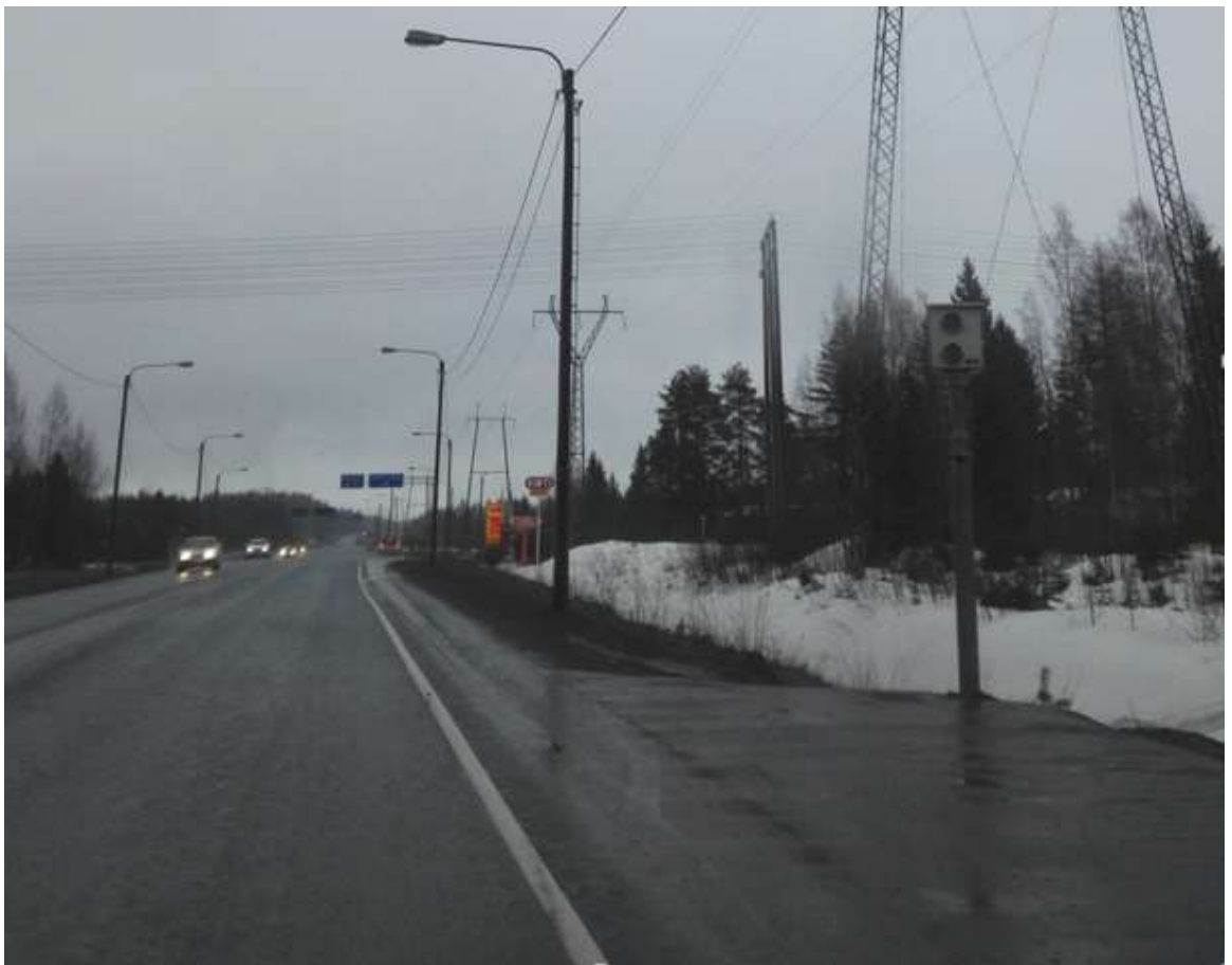
Kuva 2. Tien varressa oleva valvontapylväs (Vehviläinen 2017-04-09)
