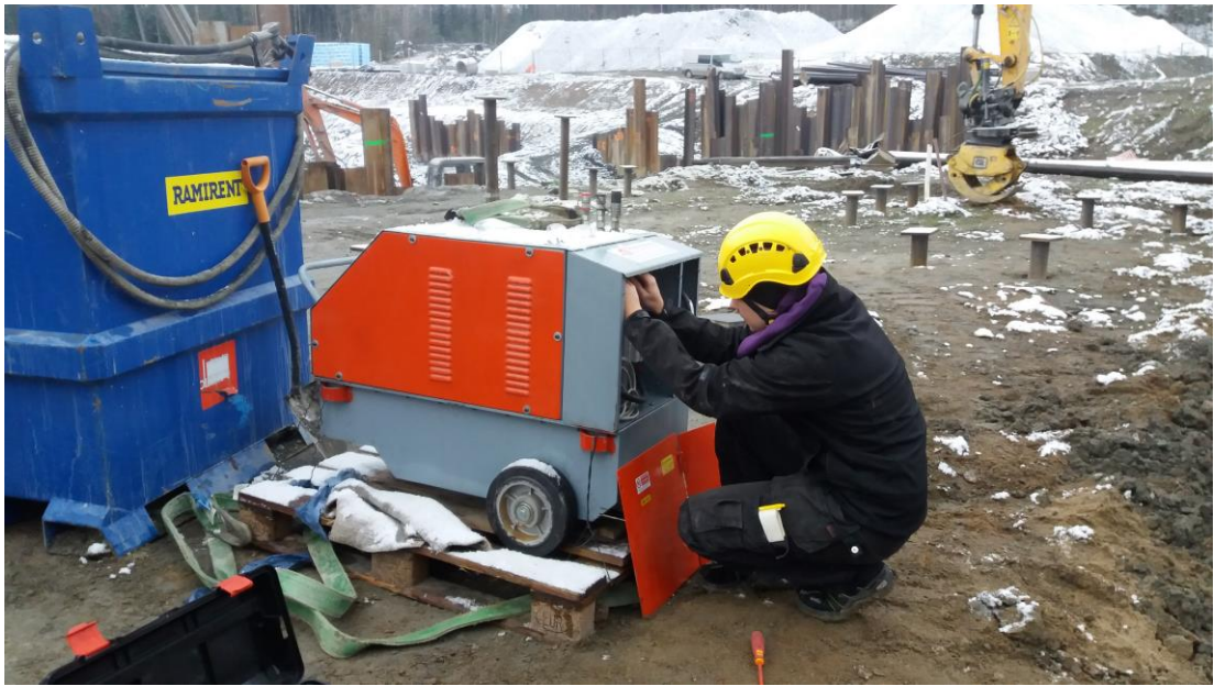
KUVA 8. Akkukäyttöisen laitteen asennus hydraulikkatunkkiin.
