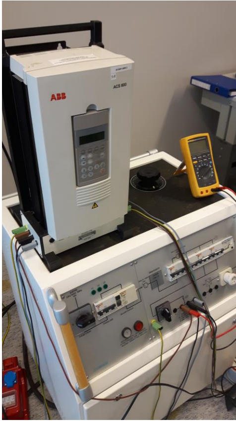
KUVA 12. Taajuusmuuttaja ja virtavaunu.
