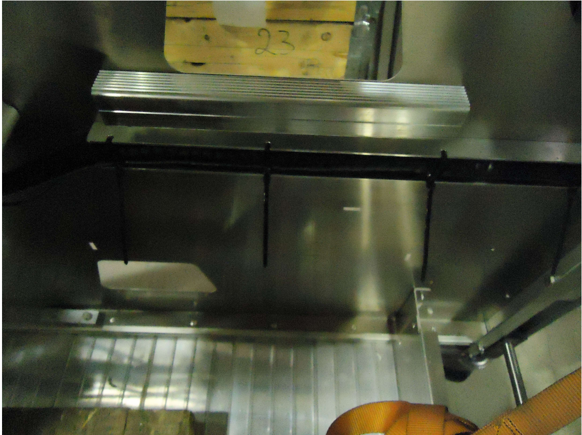
Kuva 10. Asennettu kaapeliniippu ohjauskeskukselta päädyn toimilaitteille.
