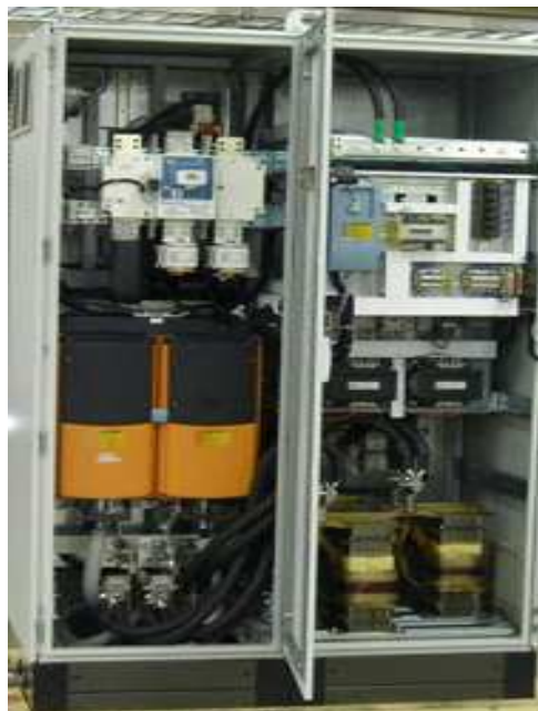
Kuva 7. Aurinkovoimalakäyttöön tehty ilmajäähdytteinen tehonmuokkain. /22/
