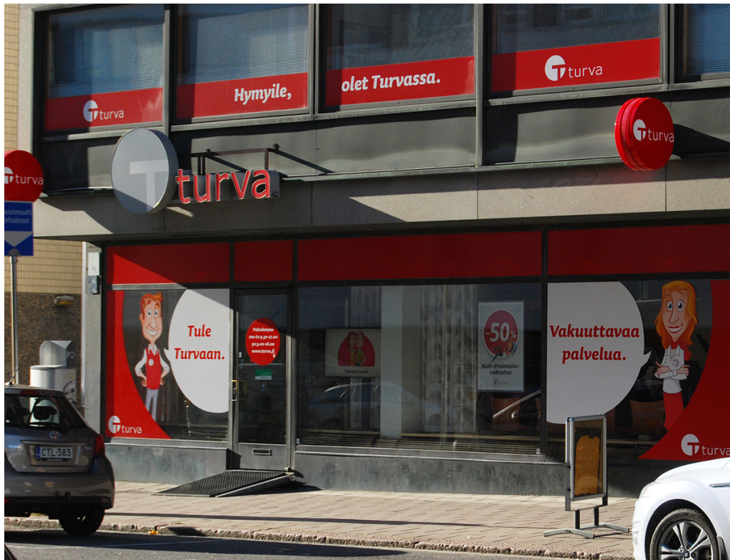
Kuva 1. Turvan kaksikerroksinen julkisivu Käsimyllykadulla.
