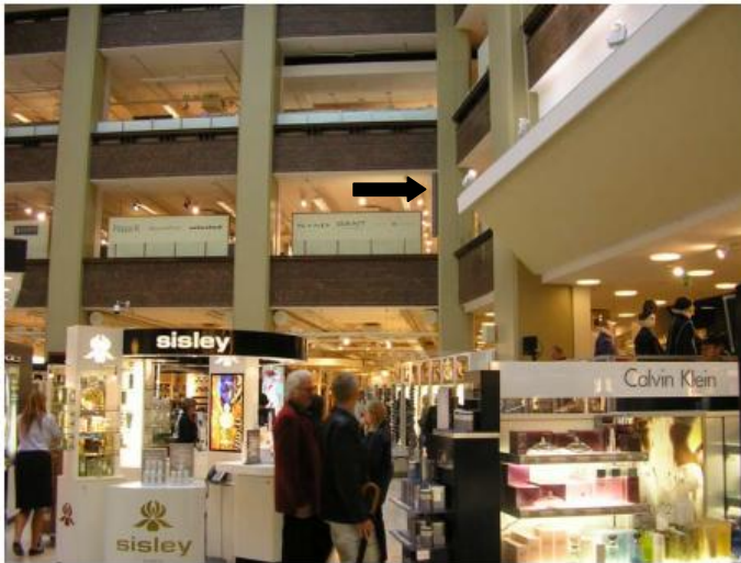
Kuva 10. Kauppakeskuksen aulatilán äänentoisto on toteutettu huomaamattomalla pilarikaiuttimella /8/.
