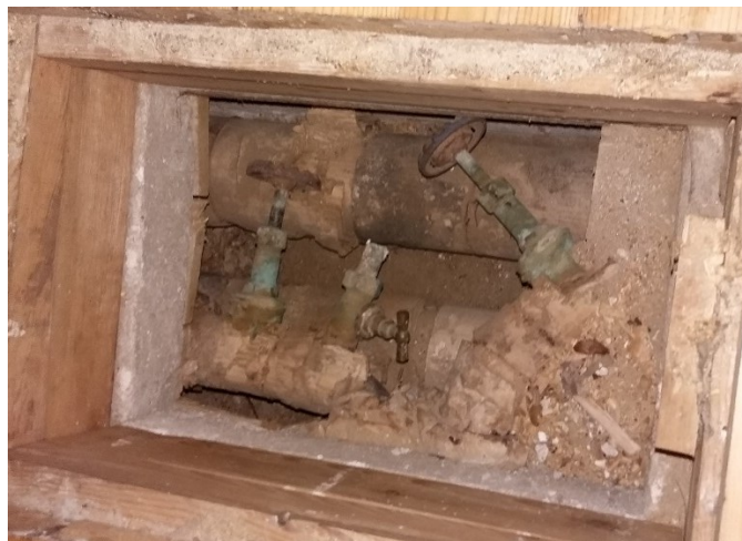
Kuva 3. Lattian alla sijaitseva putkikanava.
