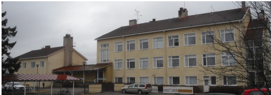
Kuva 2. Tavastilan koulu, lännen puoleinen julkisivu, vasen matalampi osa asuinhuoneistojen siipi ja oikea korkeampi koulusiipi.
