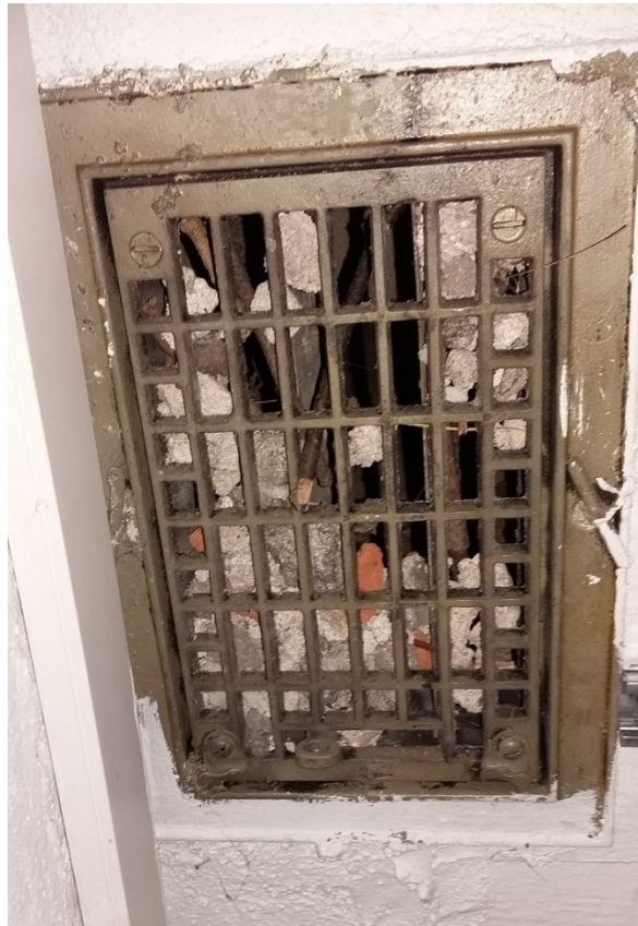
Kuva 7. Asuntosiiiven kellarikerroksen vedenspääsulkuhuoneen käytöstä poistettu hormi
