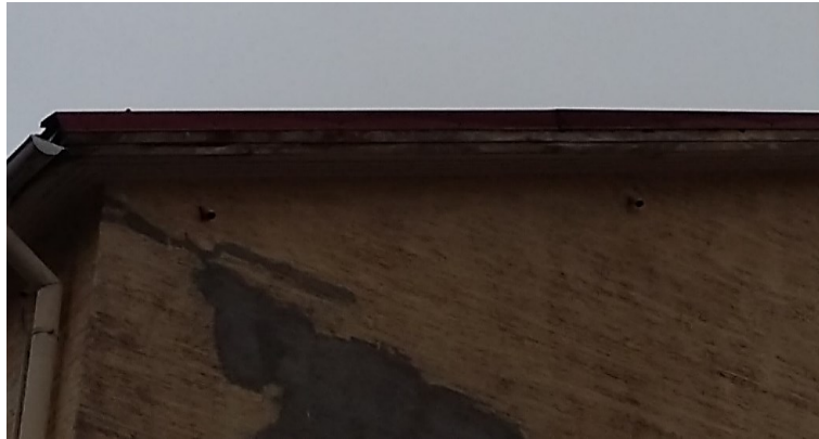
Kuva 10. Rakennuksen eteläpäädyn rappauksien paikkaus.
