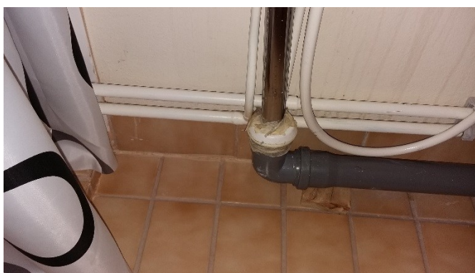
Kuva 26. Naisten wc-tilan putkien tiivistys ja kannakkeet.
