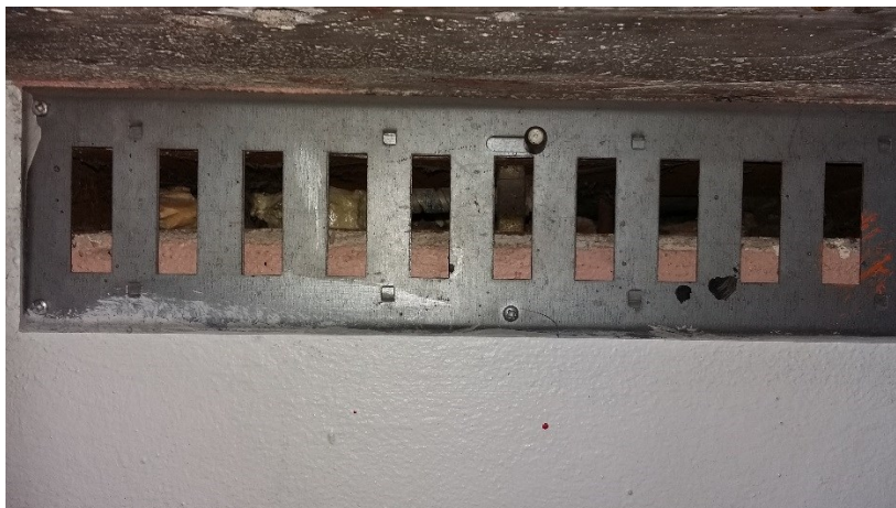
Kuva 30. Raitisilmaventtiili avattuna
