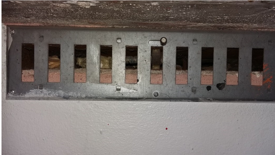
Kuva 6. Tuloilmaventtiili koulusiivessä
