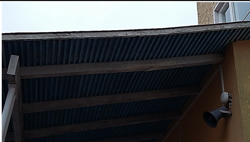
Kuva 23. Katoksen murtuneet kannakkeet.
