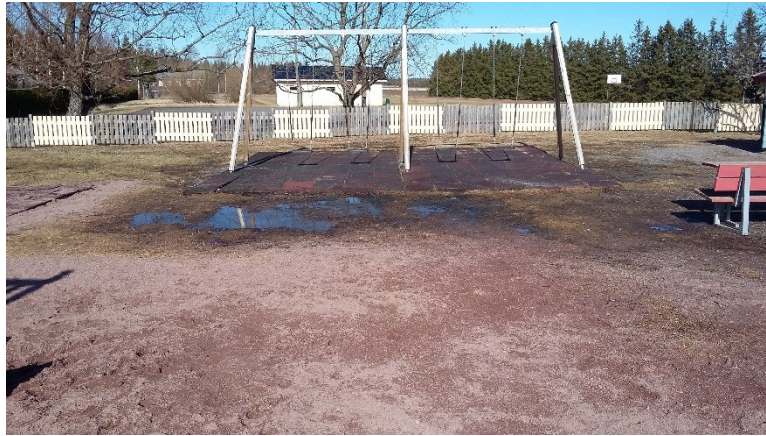
Kuva 4. Keinujen alla oleva pehmustematto, etualalla nähtävissä lammikoituvaa vettä.
