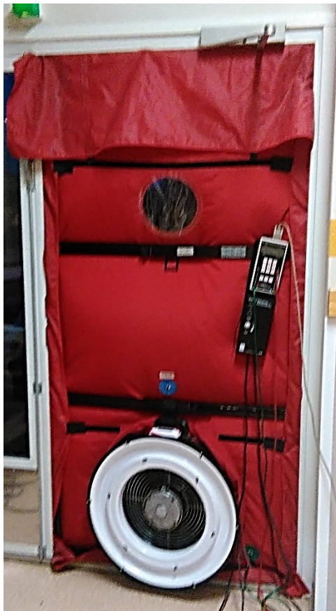
Kuva 12. Tiiviysomittauslaitteisto koottuna pelastuskäytävän oveessa.
