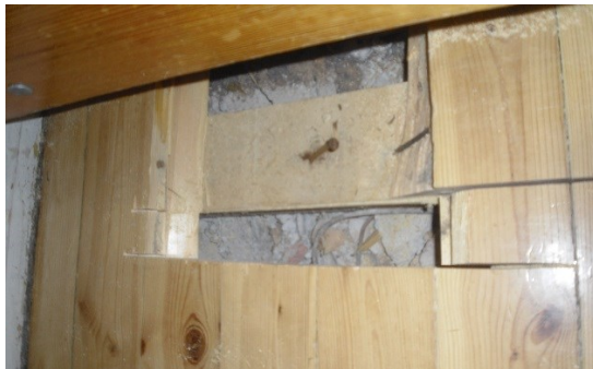
Kuva 23. Liikuntasalin lattia avattuna
