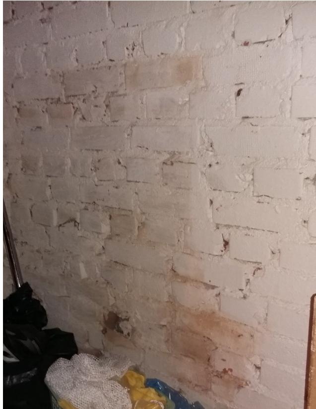
Kuva 1. Asuntosiiven kellarikomeron (varastotila nro 114) seinän värjäymä
