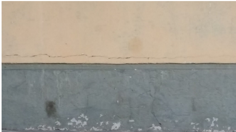
Kuva 7. Perusmuuri pääsisäänkäynnin vasemmalla puolella
