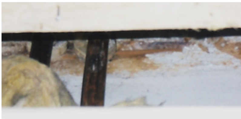
Kuva 20. Rakenneavaus putkien läpiviennin kohdalta
