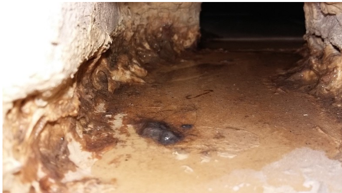
Kuva 25. Kuva suihkuveden johdattamiseen käytettävästä kanavasta.
