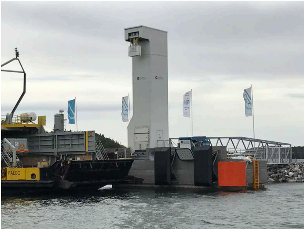
Kuva 17. Tihtaali varusteineen. Virranottotorni toimii hybridilautan latauspisteenä.
