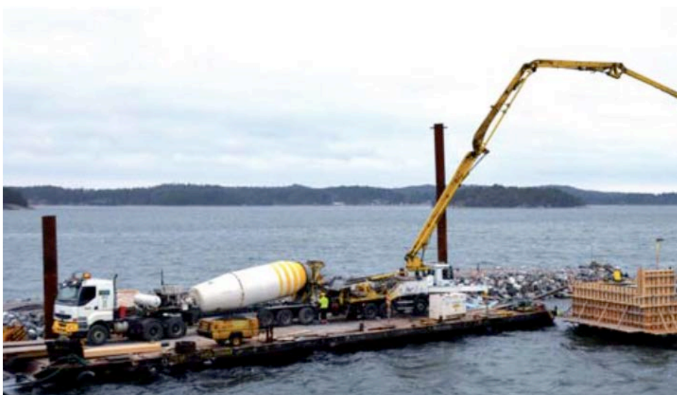
Kuva 15. Kansirakenteen betonivalutyö.
