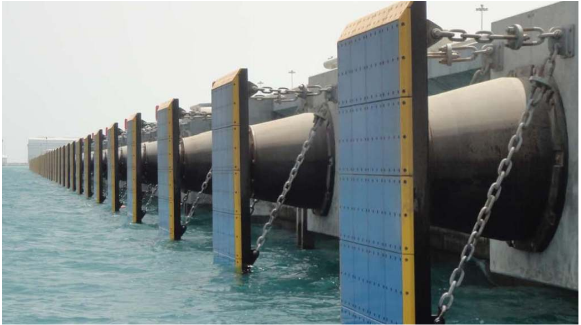
Kuva 6. Suuri fenderirakenne (Trelleborg 2017).
