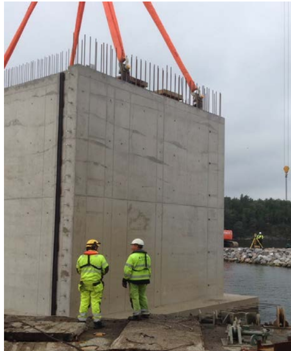
Kuva 13. Kasuunin lasku. Mittausinsinööri taka-alalla.
