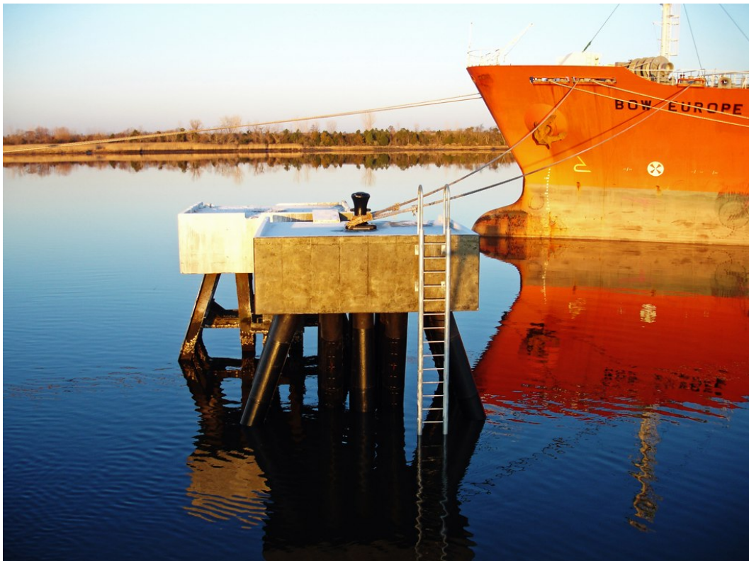
Kuva 1. Paaluperustainen tihtaali (Taylor Marine Construction 2017).
