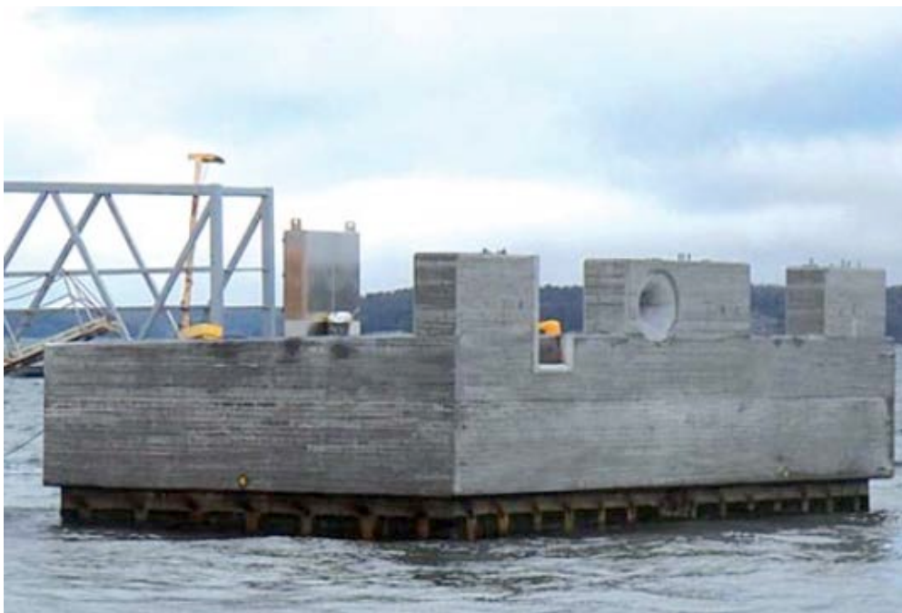
Kuva 16. Valmis tihtaali ilman varusteita.
