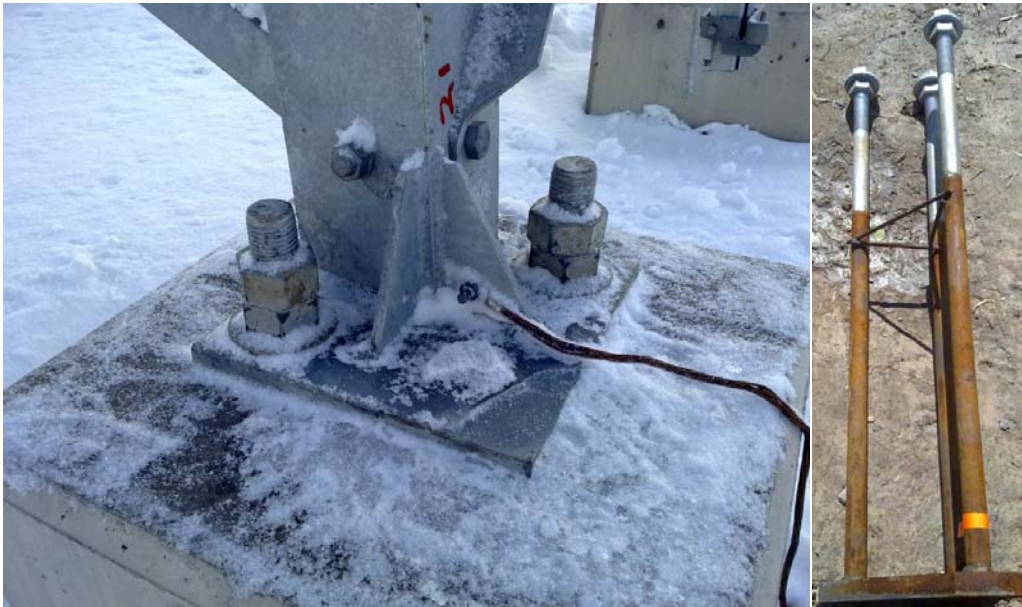
Kuva 9: Peruspulttiliitos / Kuva 10: Peruspulttiryhmä (kuvat: Mika Alisaari)
