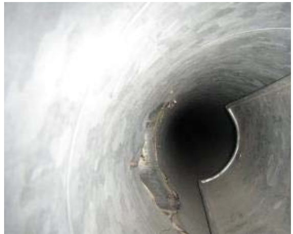
Kuva 58. Tuloilmakanavan sisäpinnoilla oli pölyä.
