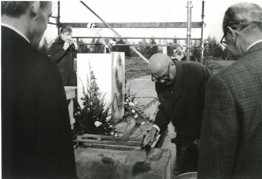
Kuva 2. Tornion terästehtaan peruskiven muuraus (YLE 2017)
