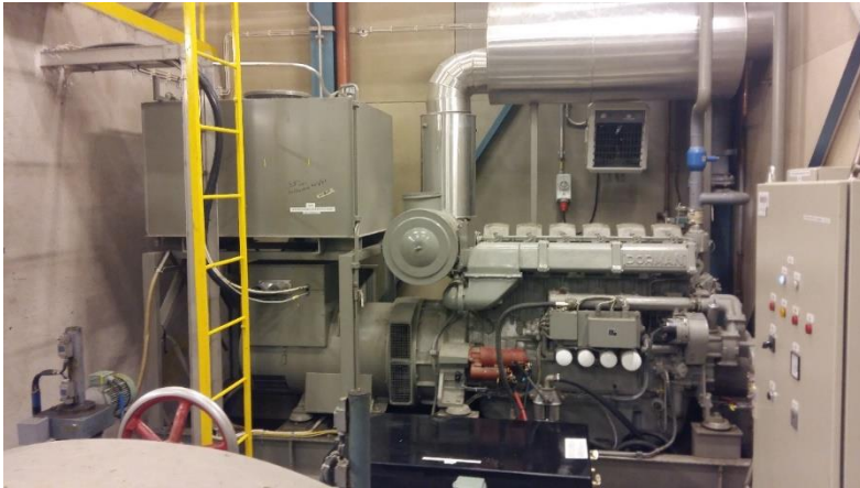
Kuva 5. Dorman diesel, dieselmoottori ja Markon generaattori
