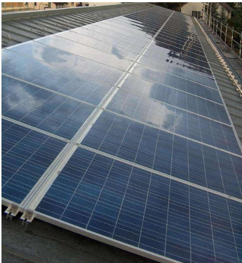
KUVA 17. Aurinkoenergiapaneelisto asennettuna kiskostoon (wikipedia 2005)
