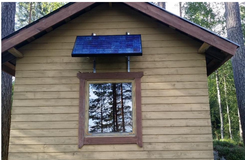
KUVA 16. Yhden aurinkopaneelin kiinnitys seinärakenteeseen (valokuva 2016)
