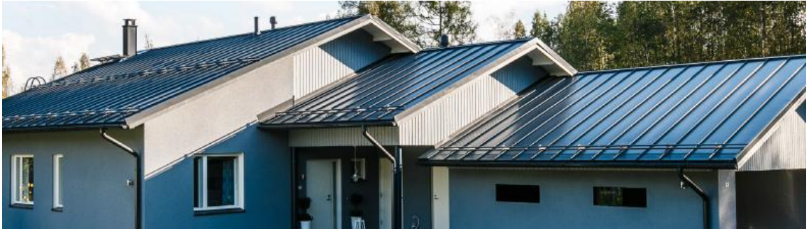
KUVA 3. Talo lukkosaumakatolla (Metehe 2017)
