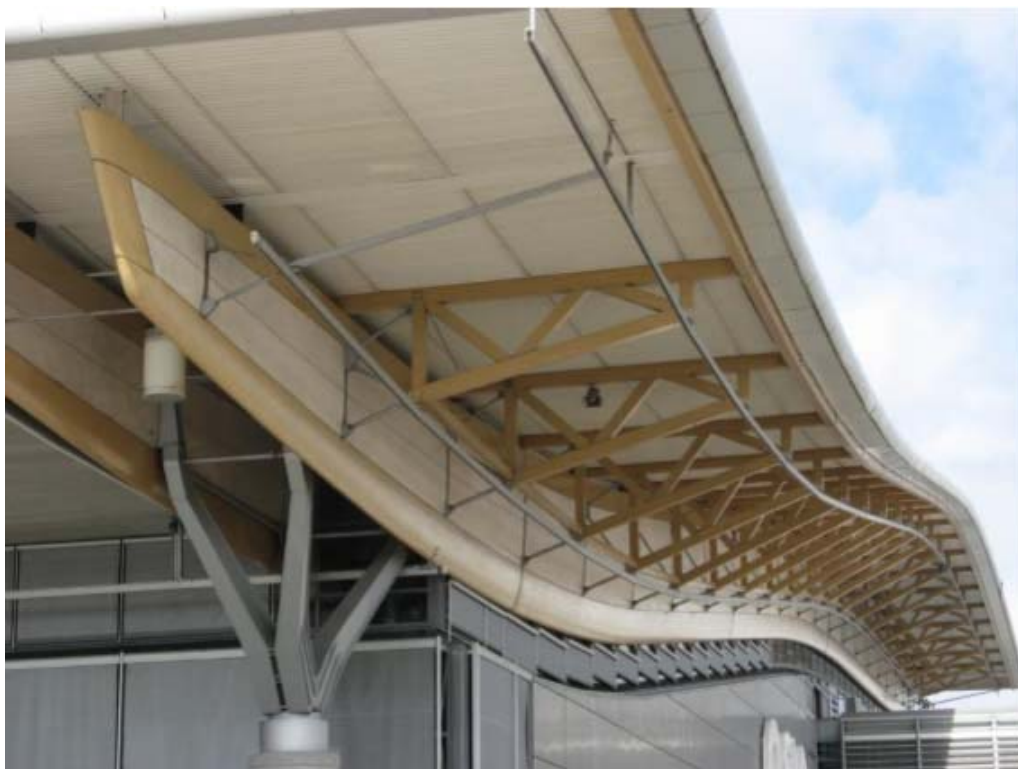
KUVA 5. Liimapuusta valmistettu Gardermoen lentokentän laajennuksen pääpalkki (Puuinfo.fi b, 14)
