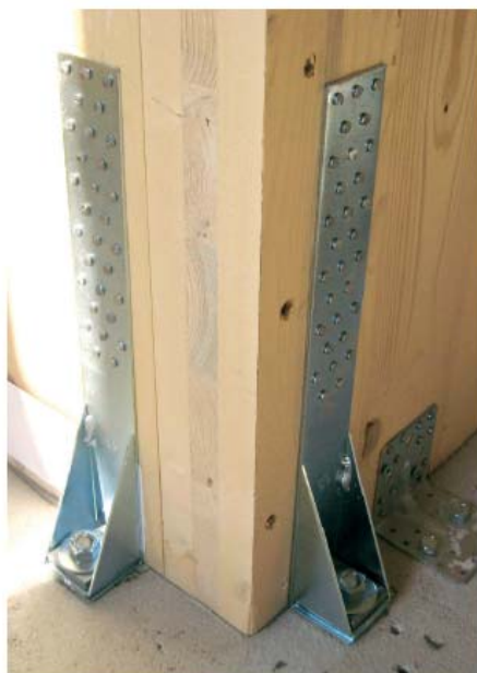
KUVA 42. CLT-seinän ankkurointi alustaan (CrossLam.fi a, 4)
