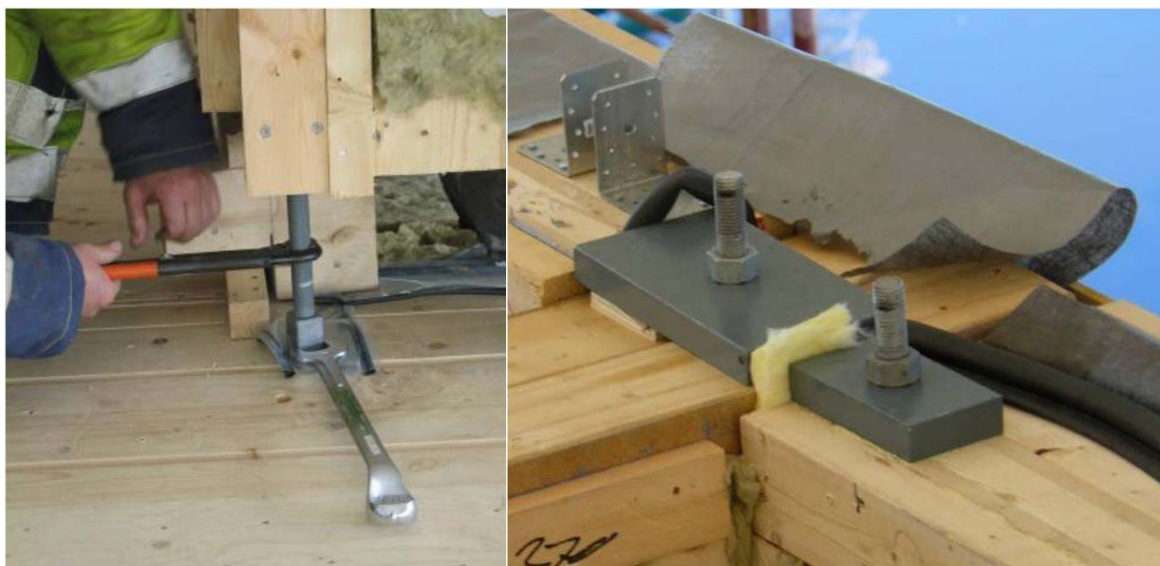
KUVA 30. Jäykisteseinien ankkurointi vetotangon avulla
