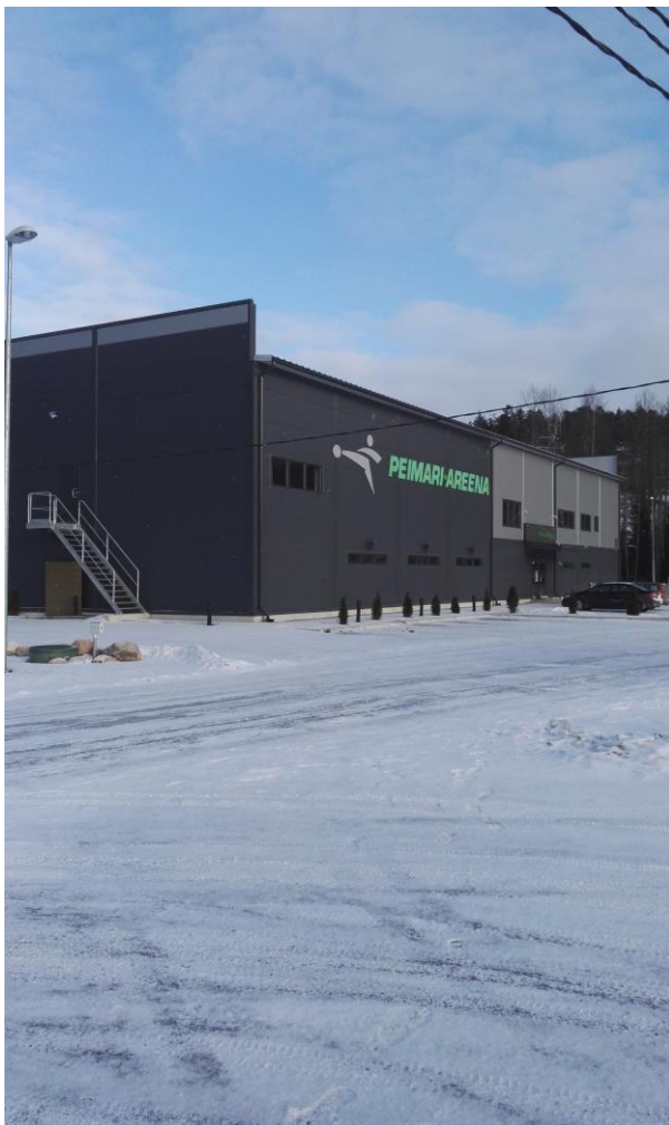
Kuva 2. Ulkopuolelta monitoimihallista otettu kuva
