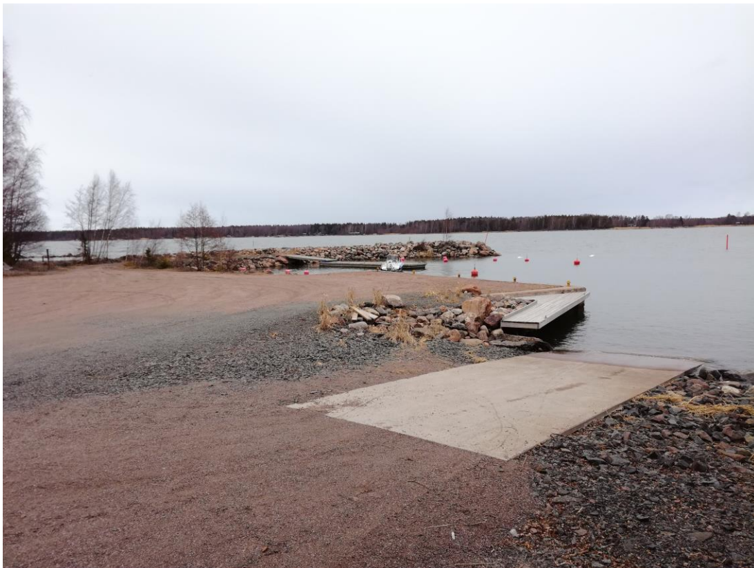
Kuva 11. Kuivalahden venesatama ja sen betoninen luiska (Hirvilammi, 2017)
