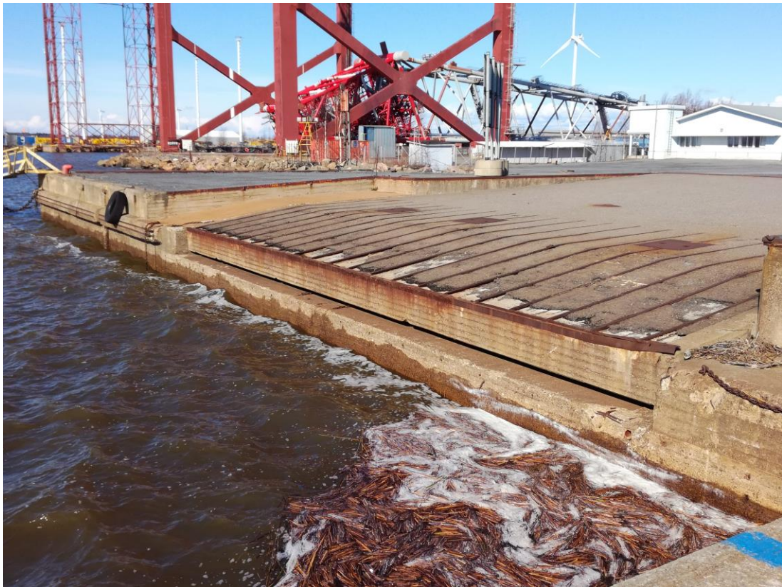
Kuva 8. Mäntyluodon sataman roro-ramppi (Hirvilammi, 2017)
