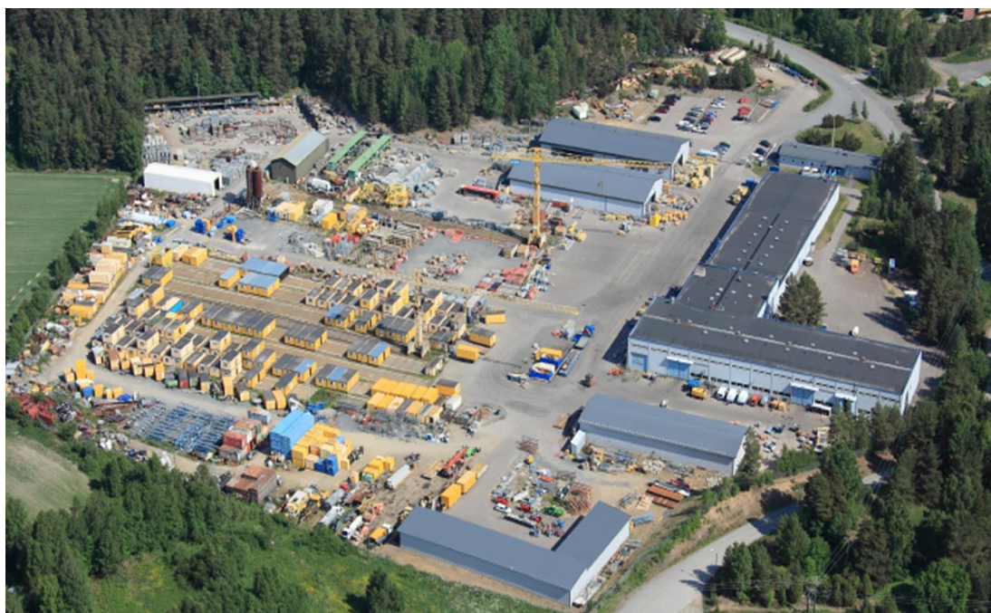
Kuva 2. YIT Kalusto Oy Urjalan kalustokeskus (YIT Kalusto Oy 2016)
