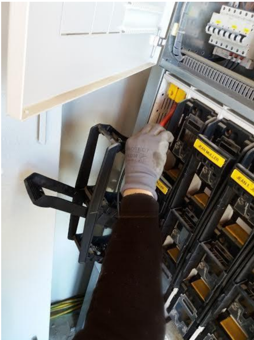
Kuva 20. Silmukkaimpedanssin mittaaminen (Veli-Pekka Lempiö)
