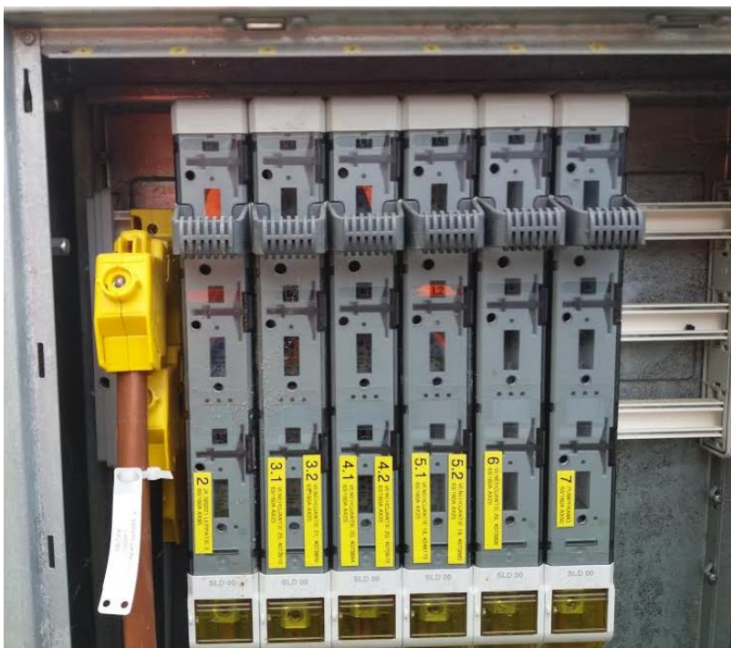
Kuva 4. Jakokaappi ja jonovarokeytkimet (Veli-Pekka Lempiö)
