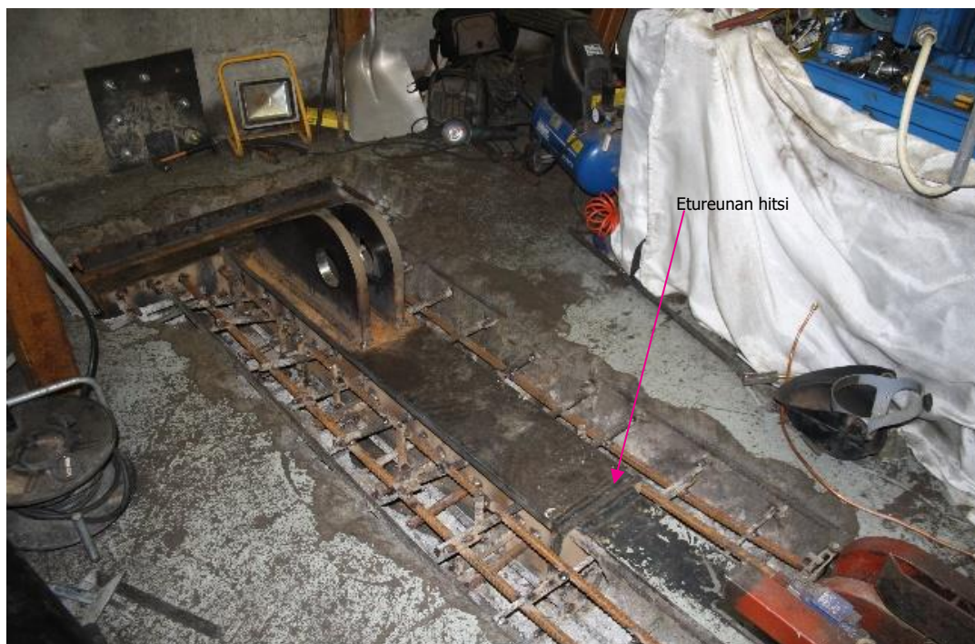
Kuva17. Sylinterin kiinnityksen asetettu paikalleen (Aarne Havukainen 2016-04-03)
