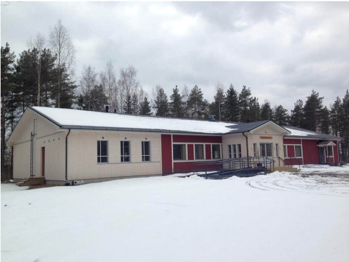
KUVA 1. Raution seudun Rauhaniyhdistyksen toimitalo
