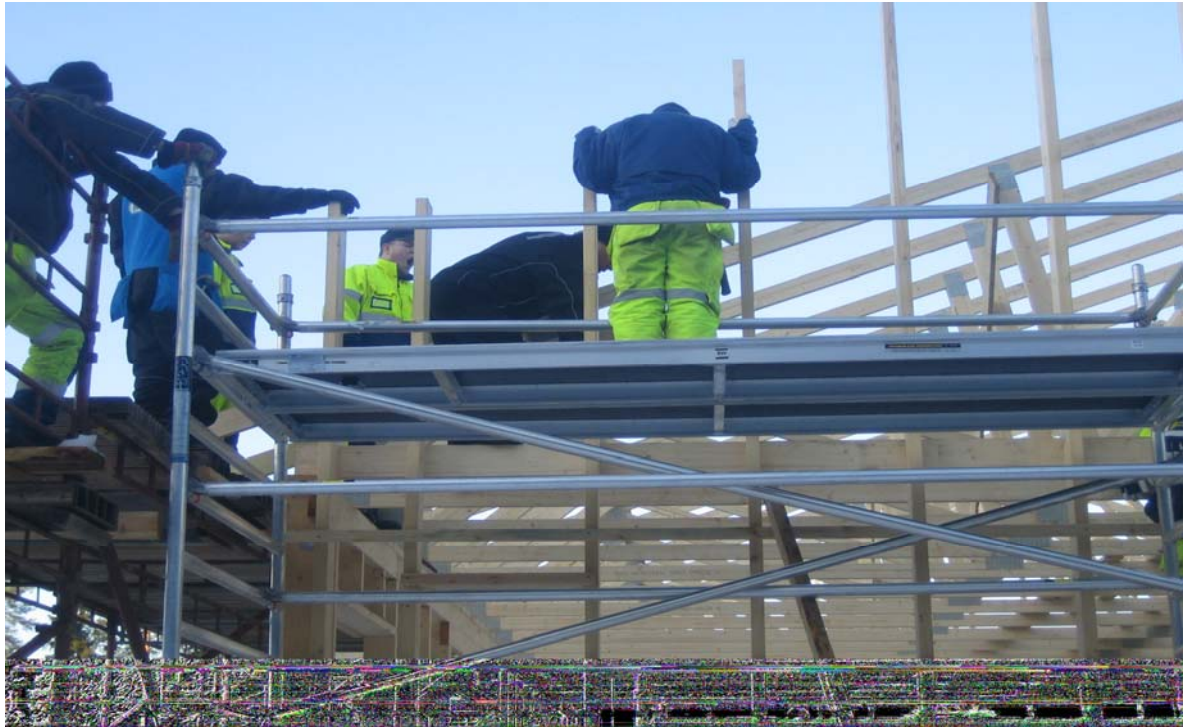
Kuva 7 Kappaletavarasta tehdyn talon päätyräystäsrakenne työn alla. Kuvassa RA08B:n oppilaita telineillä. Opettaja Risto Karjalainen opastaa oppilaita. Omakotitalot rakennetaan perinteisellä kappaletavarajärjestelmällä.
