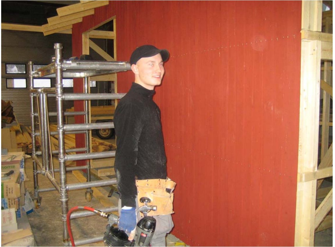
Kuva 11. Konsta Kemppainen, taitajakisoihin osallistunut, keväällä 2009 valmistuva ammattimies. Konstan opinnäytetyönä ja talonrakentamisen näyttönä on varaston rakentaminen.
