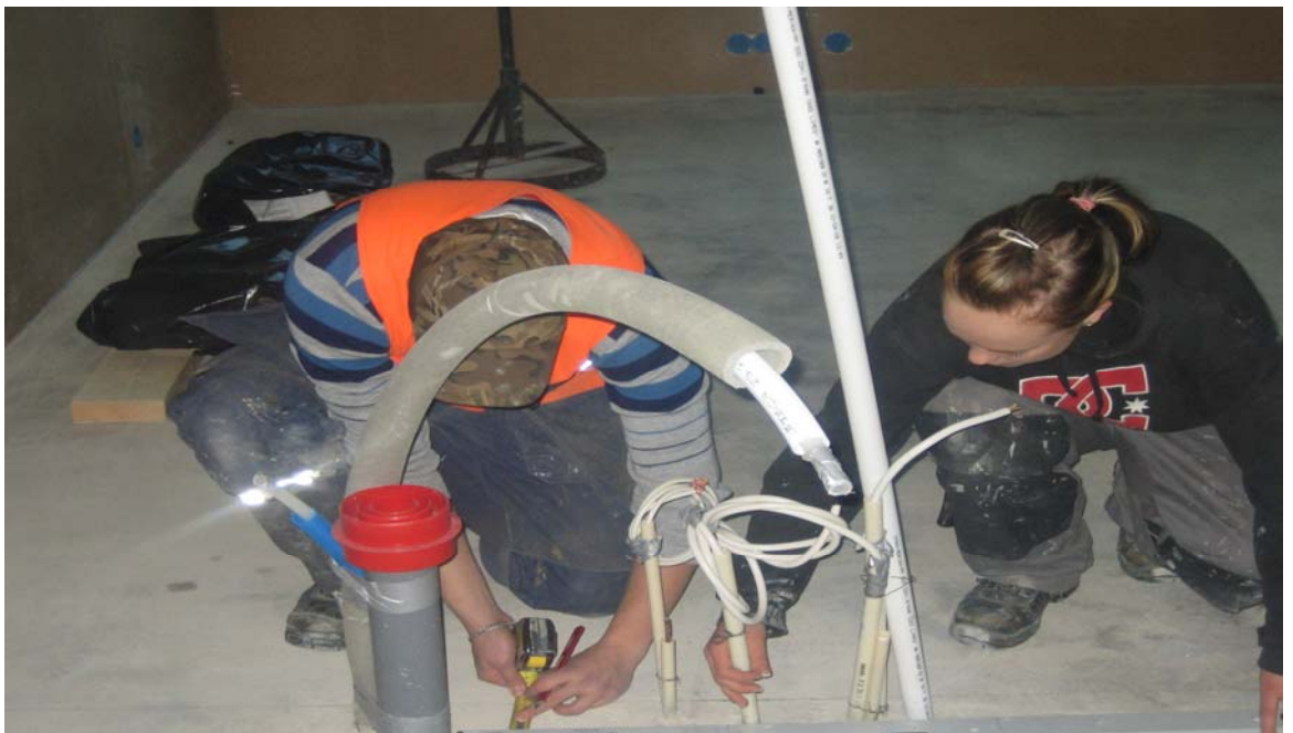
Kuva 8. Väliseinärunkojen mitoitus käynnissä. Väliseinät tulee saada tarkasti paikoilleen ja lattiasta tulevat sähkö ym. putket seinän sisälle. Rakennusosalalla opiskelee silloin tällöin myös tyttöjä. Kuvassa Enni Kananen mittaustöissä. Enni on vuoden 2006 Taitaja 9 -kilpailujen Suomen mestari, kaverina Ville Kempainen
