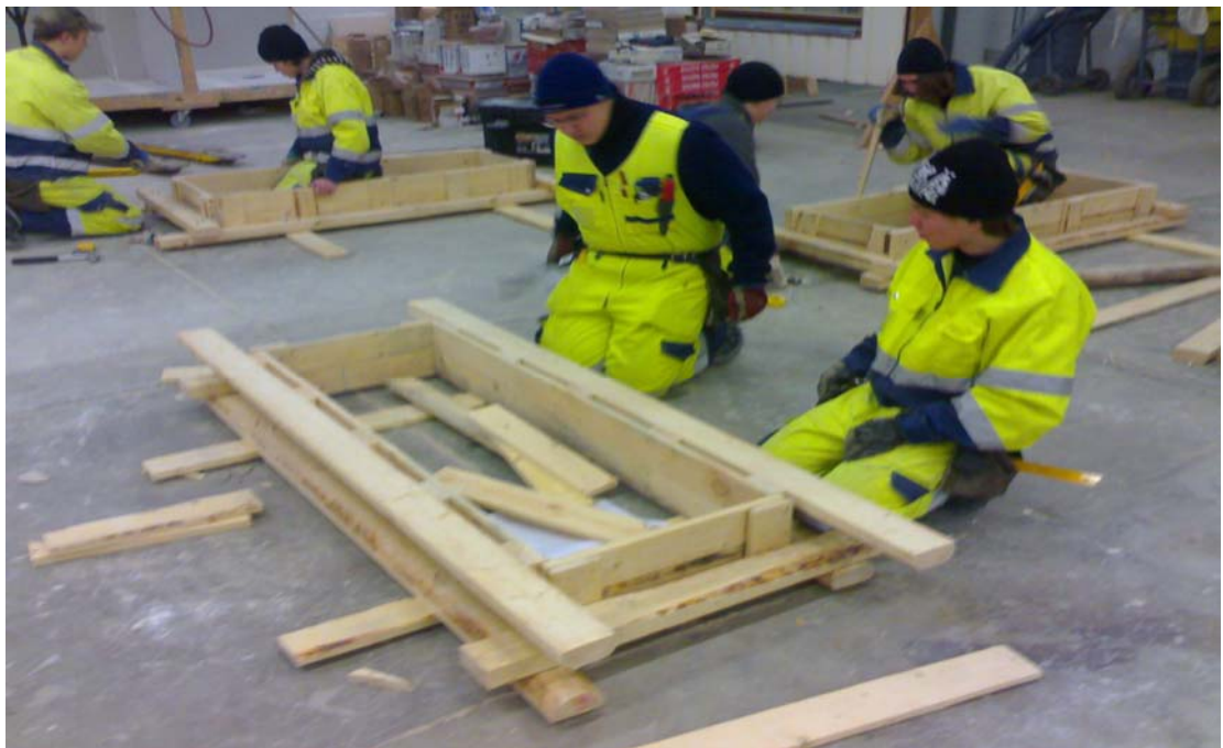
Kuva 10. Olli-Pekka Möttönen ja Jarkko Huotari perustusmuotin teossa. Perustustöiden näyttö tehdään halliolosuhteissa. Muotin teko on yksi vaihe moniosaisesta näytöstä.
