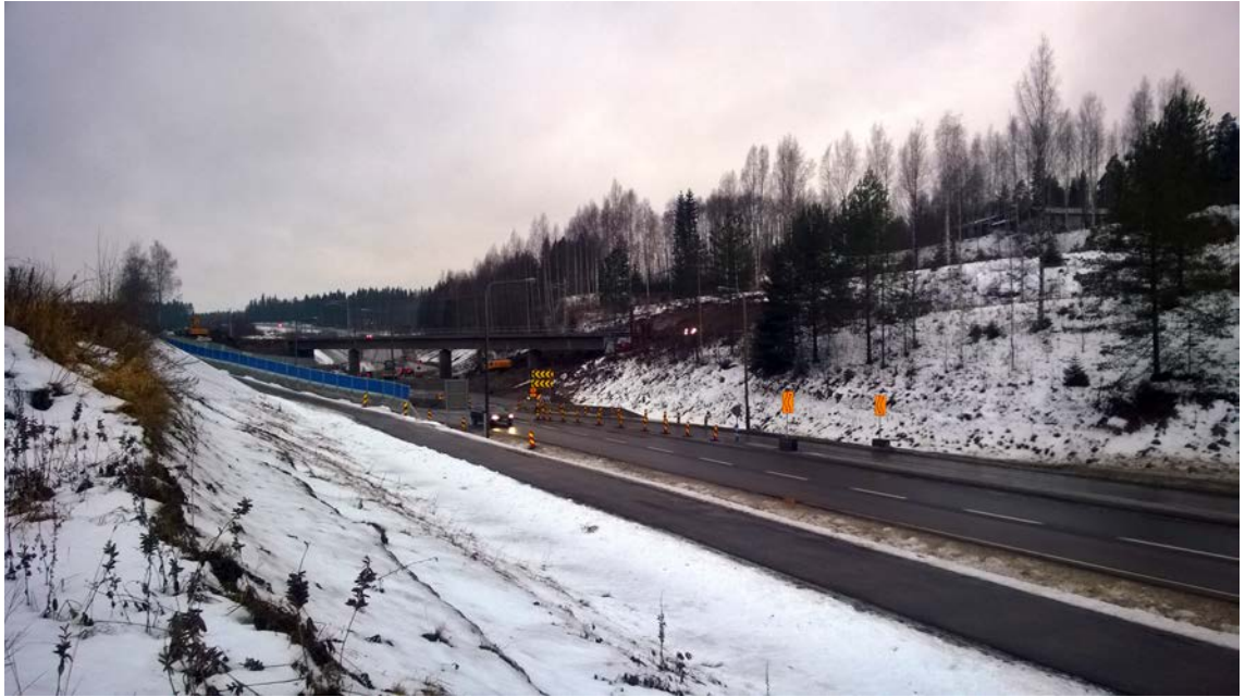
KUVA 13. Siltatyömaan pohjoispuoli Jyväskylän suuntaan nähtynä
