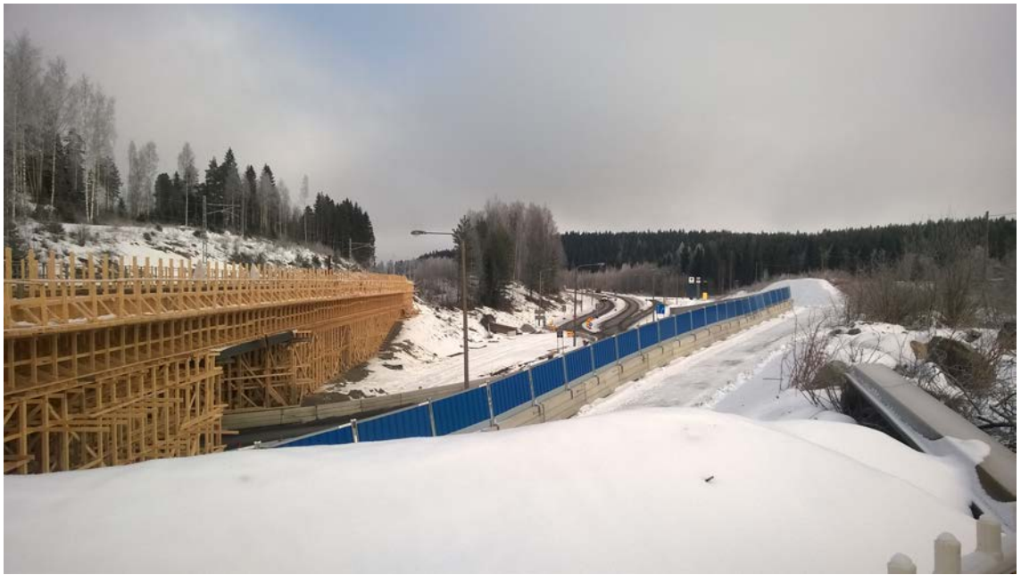
KUVA 15. Siltatyömaan pohjoispuoli Laukaan suuntaan nähtynä uuden sillan muottien ollessa valmiit
