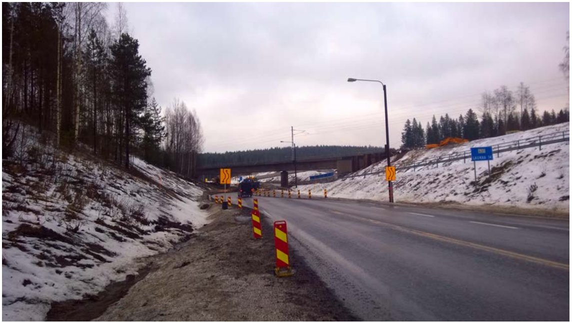
KUVA 17. Siltatyömaan eteläpuoli Laukaan suuntaan nähtynä
