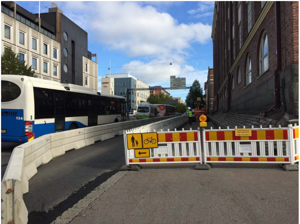
KUVA 8. Sulkuaita erottaa kevyen liikenteen ja työalueen, ja betoninen työaikainen suojakaide erottaa ajoneuvoliikenteen kevyestä liikenteestä (Kuva: Henri Mäkinen 2016)
