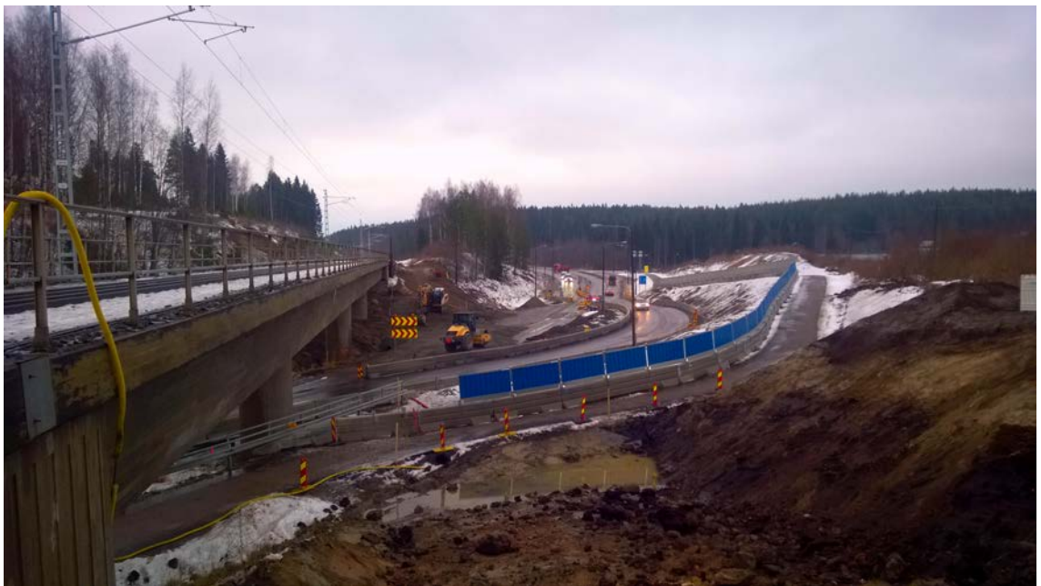
KUVA 14. Siltatyömaan pohjoispuoli Laukaan suuntaan nähtynä
