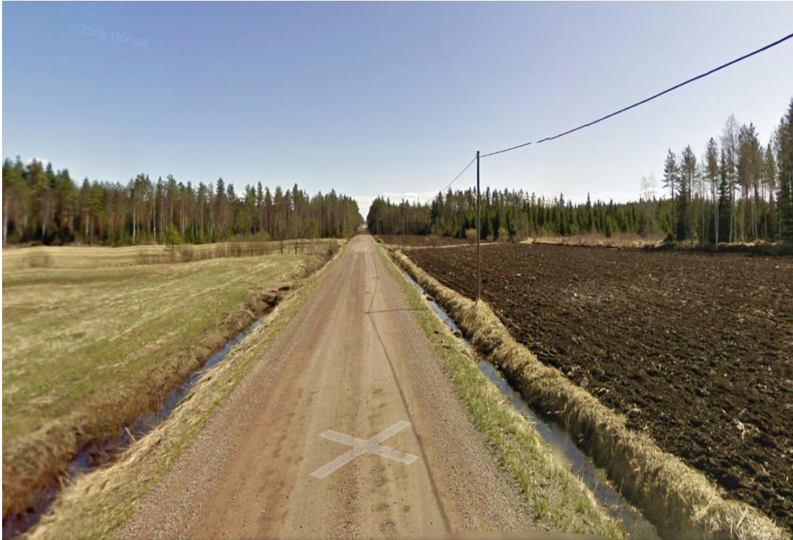
KUVA 17. Kankaantie 18155, tieosa 003, paaluväli 2030-2900.
