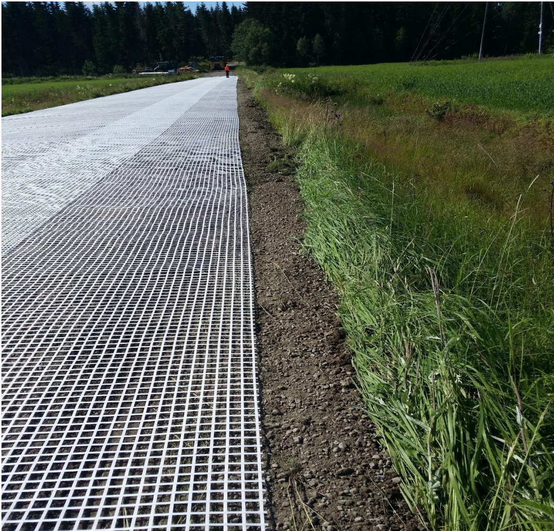
Kuva 20. Lujiteverkon reunan sijoittaminen
