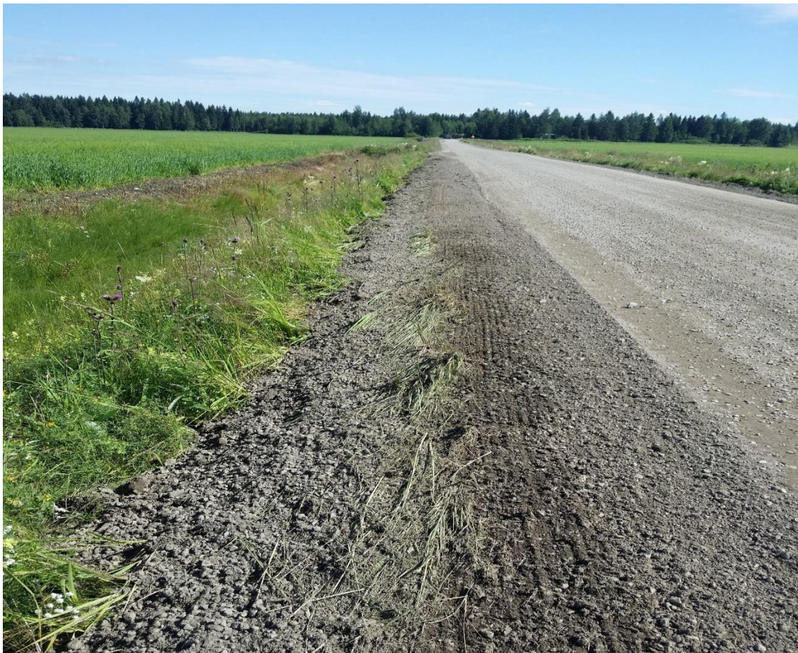
Kuva 19. Tasattu vanha kulutuskerros
