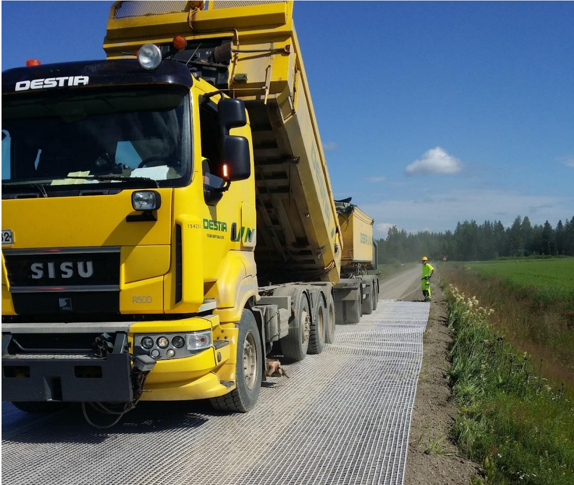
Kuva 21. Uuden kantavan kerroksen rakentaminen
