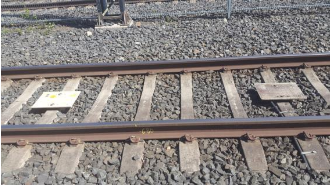
KUVA 2. Ohjattu ja ohjaamaton baliisi radalla.
