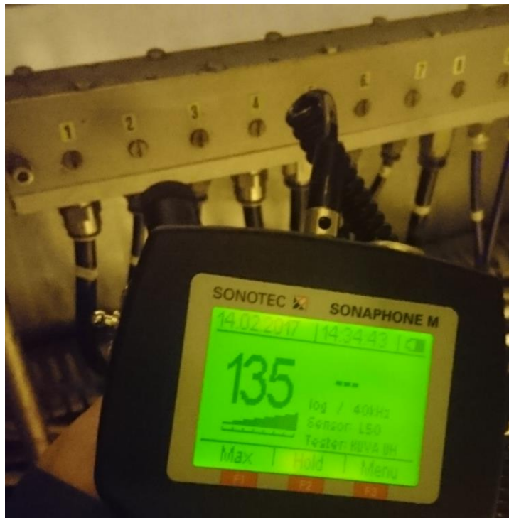
Kuva 6 Vuotojen havaitseminen SONOTEC SONAPHONE M mittarilla
