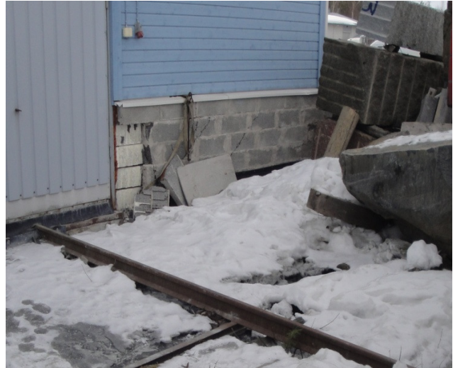
← Vanhan osan/hallin sokkelien epätiivis yhtymäkohta etelän puoleisessa sokke- lissa. Kuvat ovat otettu ulkoa ja sisä- puolelta.
