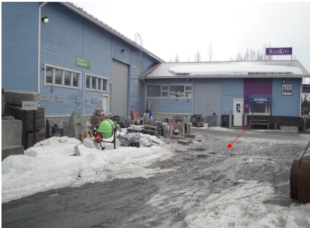
Rakennuksen etupihan yleisilmettä. Kunnallinen sadevesikaivo on merkattu kuvaan nuolella.
