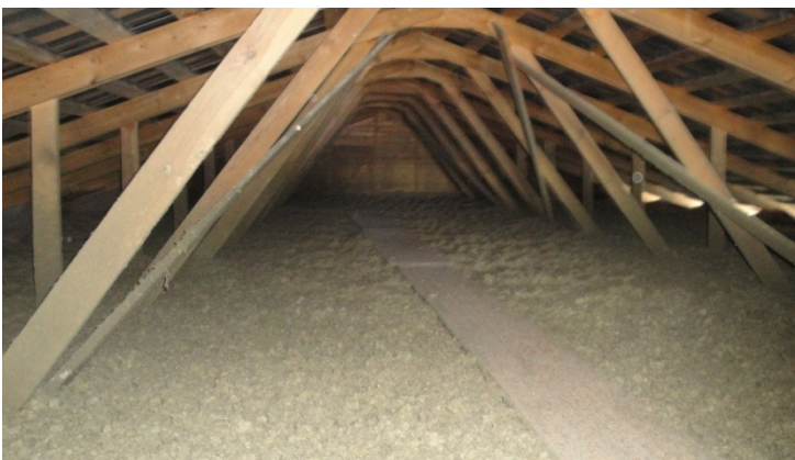
Kultaushuoneen yläpohjatilaa. Kulkusilta ei jatku päätyyn saakka.
