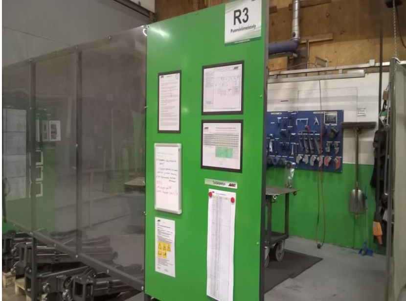
KUVA 59. Viimeistelysolun uudet suojaseinät ja infoseinä.
