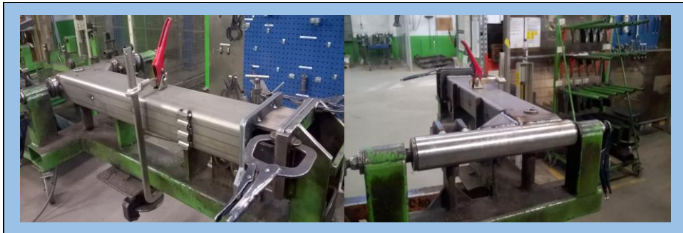
KUVA 32. 600- sarjan tyvipuomi silloitettuna jigissä.
