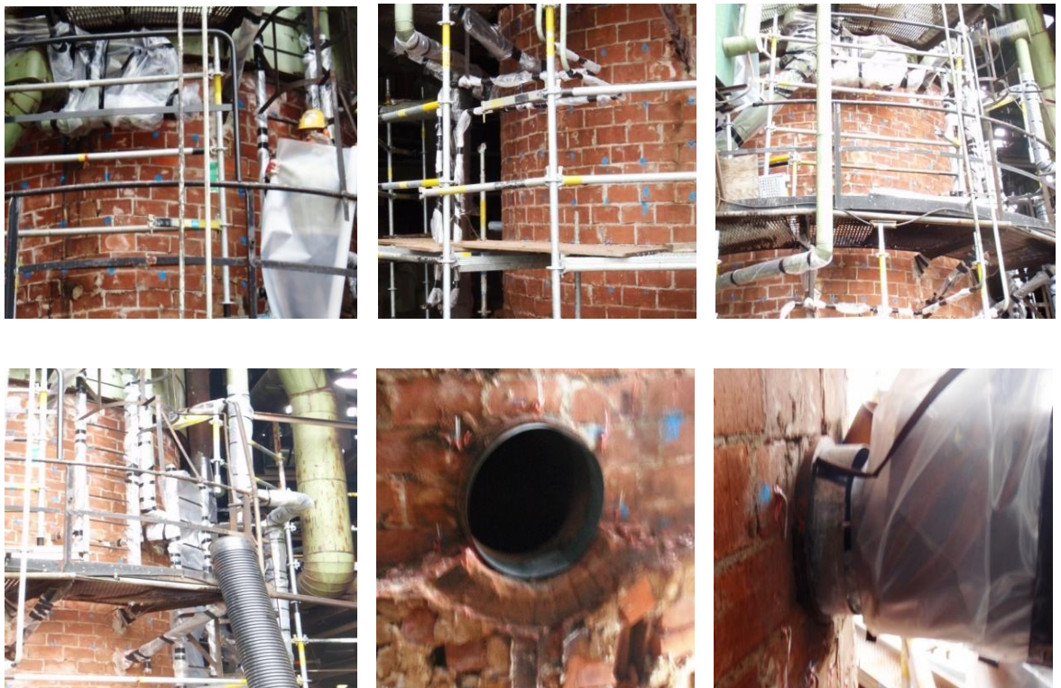
Kuvio 5. Kuvasarja kolonnin helman suojaus- ja raudoitusyöistä
