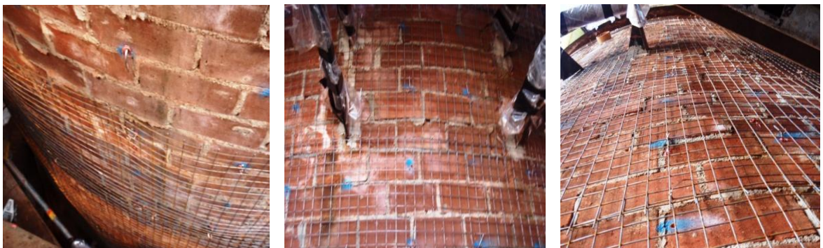
Kuvasarja kolonnin helman suojaus- ja raudoitustöistä
