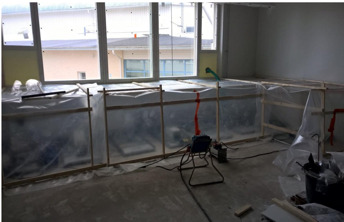
KUVA 16. Nykyään reunavahvistetun laatan kuivumista voidaan jouduttaa kuvan mukaisesti kierrättämällä lämmintä ja kylmää ilmaa hyvin tiiviissä tilassa sekä/tai lämmityslevyillä. Näin laattaaan ei jää rakentamisesta aiheutunutta kosteutta. (Brandt 2017)
